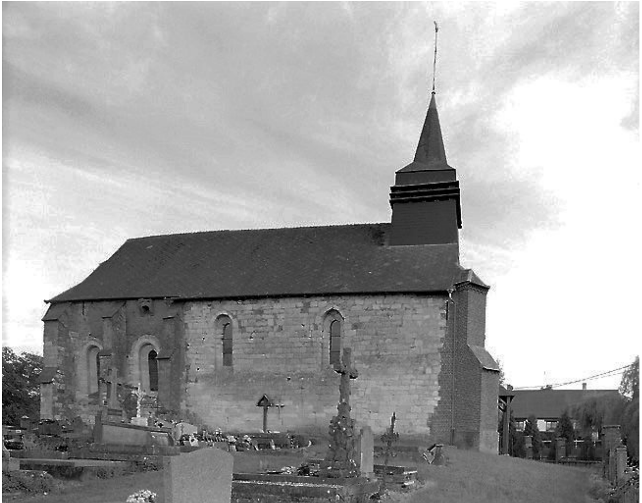
Elévation nord de l'église depuis le cimetière.
