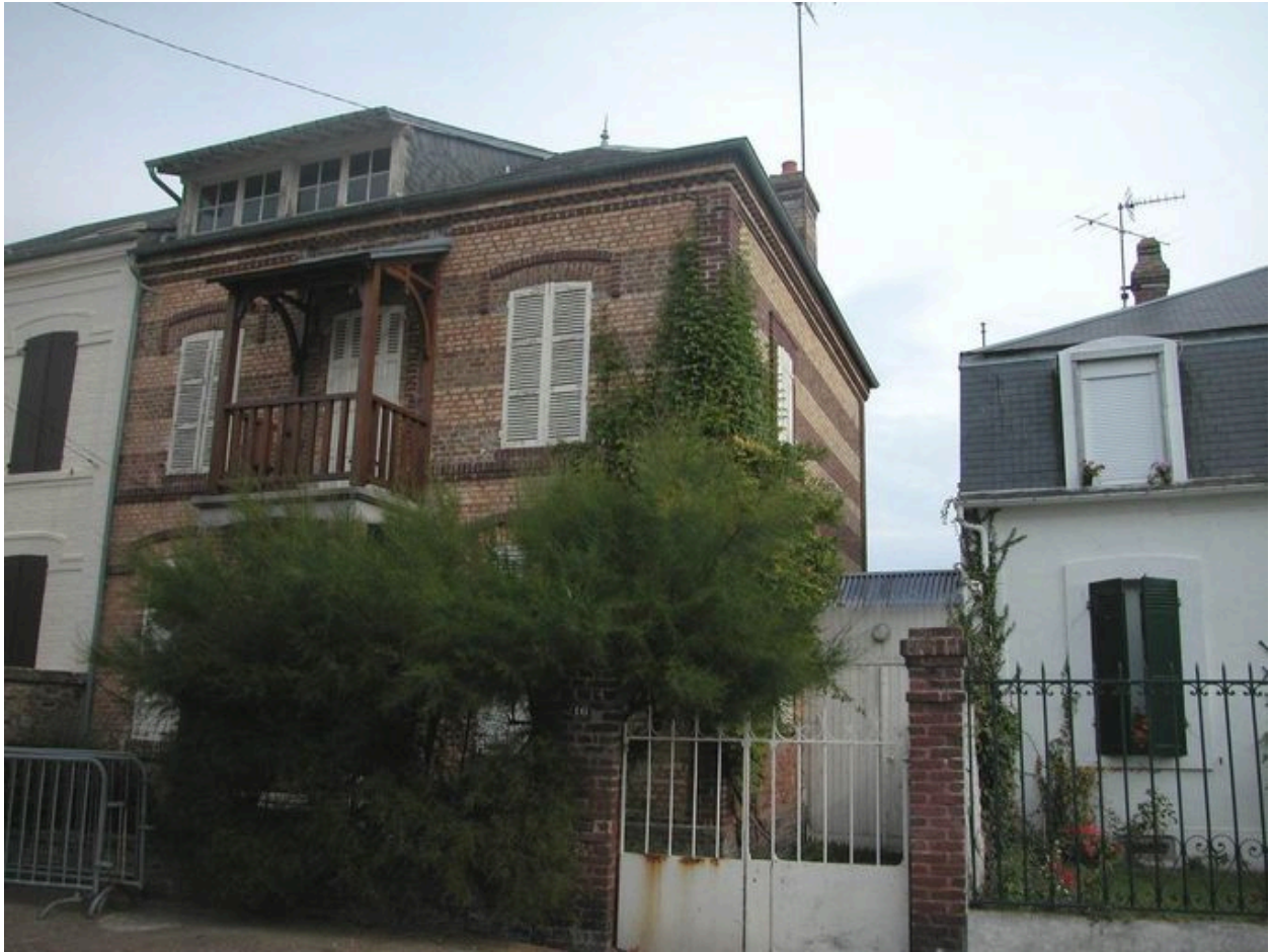
Vue de trois-quarts avec détail du muret de séparation percé d'une porte.
