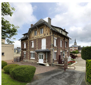
Vue générale, façade sur jardin, vue de trois-quarts. Phot. Thierry Lefébure IVR32_20160200106NUC2A
