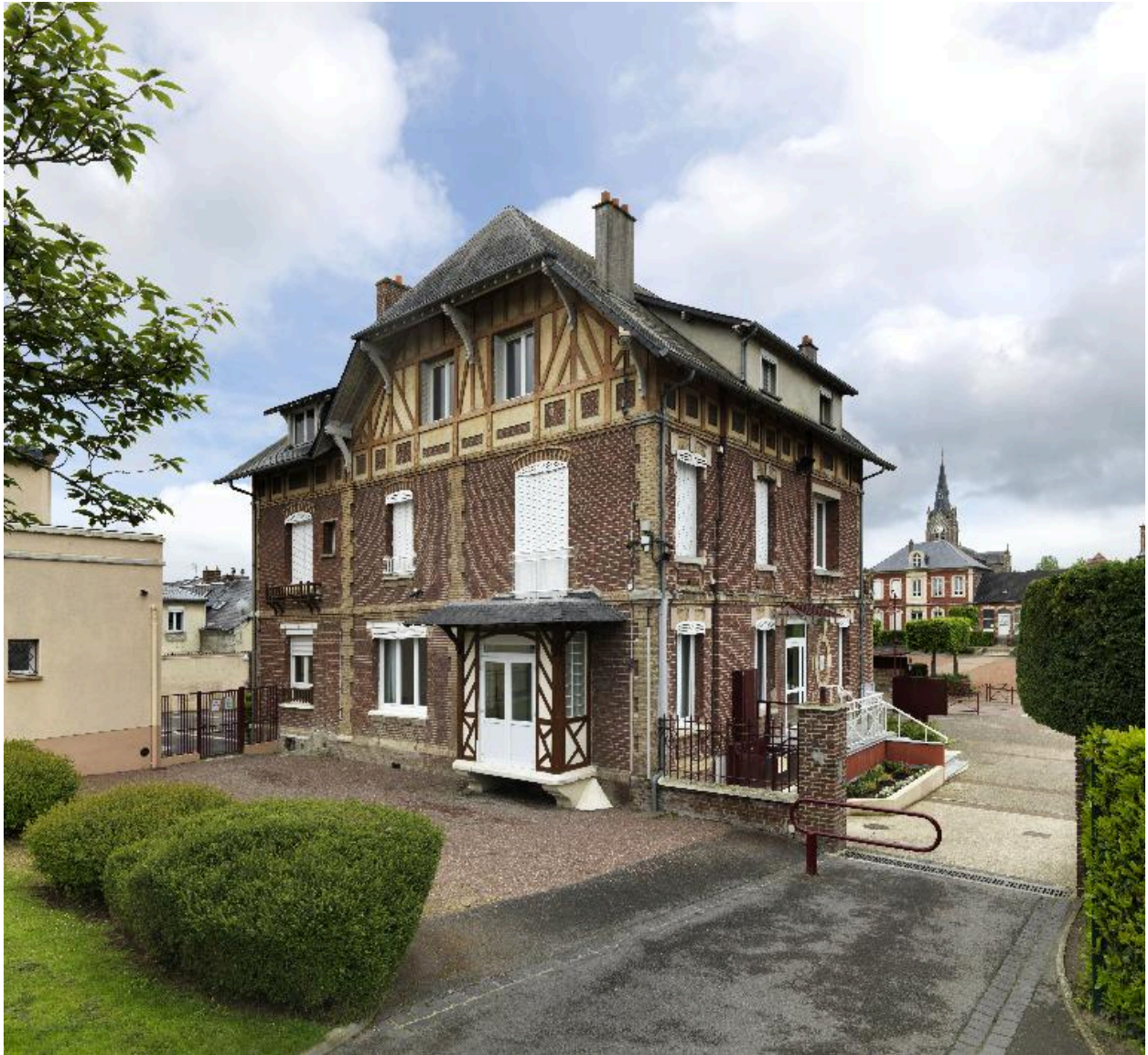
Vue générale, façade sur jardin, vue de trois-quarts.
