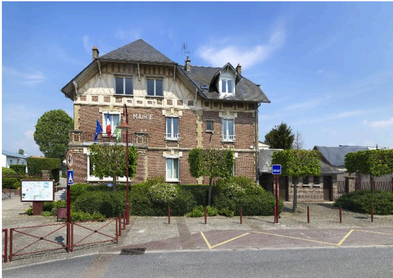
Vue générale, façade sur rue.
