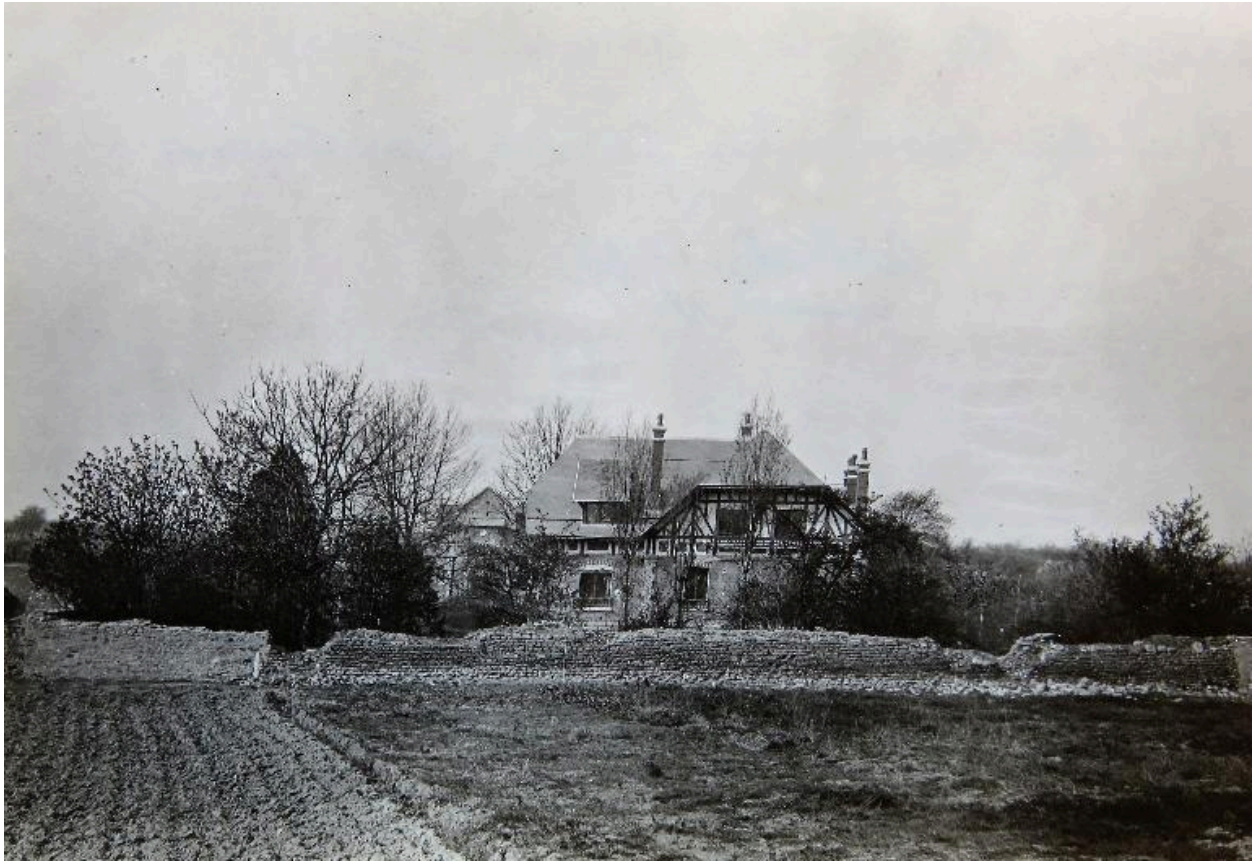
La villa Grand-Mère en cours de reconstruction, vue de situation depuis le nord-est, avril 1922 (coll. Martine Hilt-Maguin).
