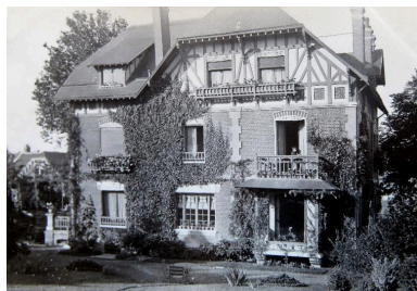
La villa Grand-Mère reconstruite, façade sur jardin, septembre 1926 (coll. Martine Hilt-Maguin). Phot. Martine Hilt-Maguin (reproduction) IVR32_20160205183NUCA
