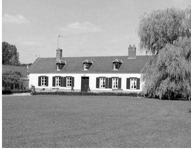
Façade antérieure du logis. Phot. Irwin Leullier IVR22_19978000627X
