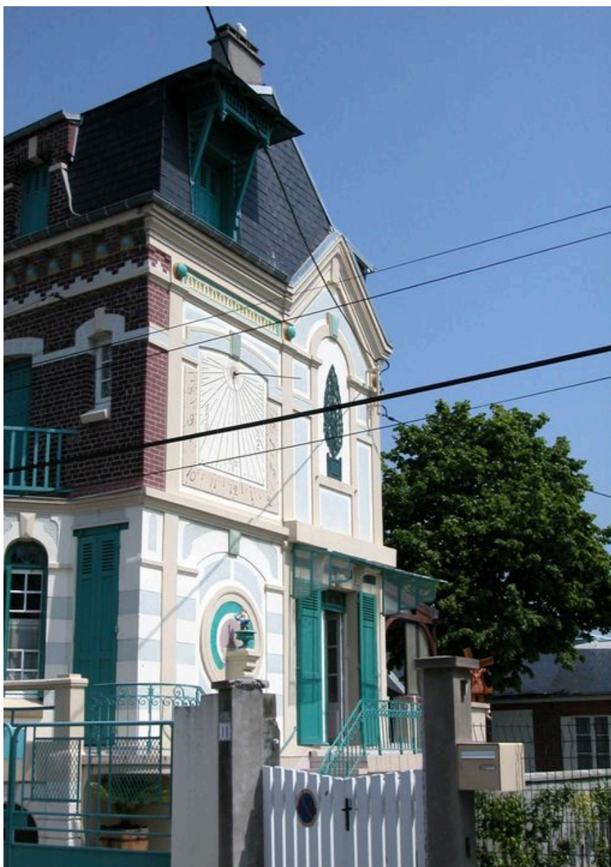
Vue rapprochée de la façade latérale droite.
