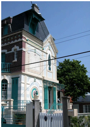
Vue rapprochée de la façade latérale droite. Phot. Elisabeth Justome IVR22_20058002660NUCA
