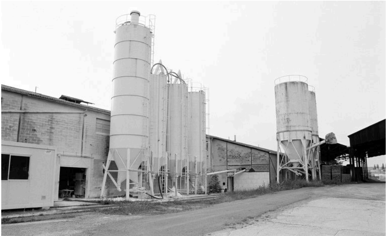
Silos et réservoirs d'eau.
