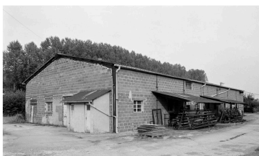
Atelier d'entretien et de réparation mécanique. Phot. Bertrand Fournier IVR22_20006000856Z
