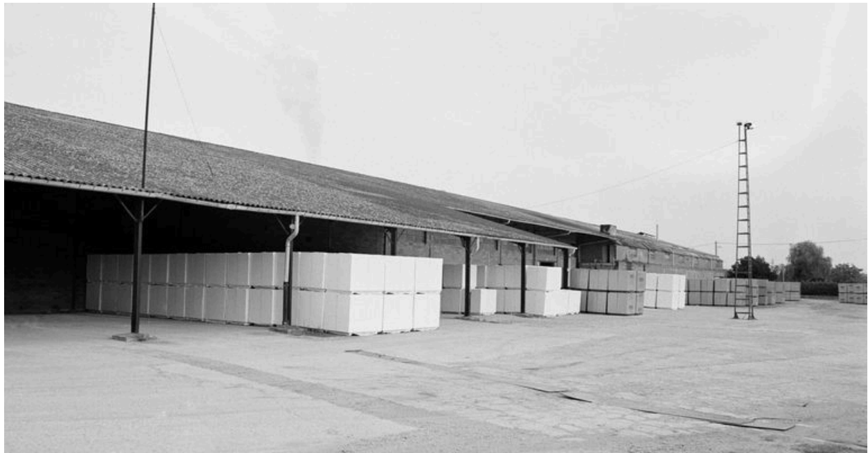
Atelier de fabrication et aire de stockage des produits finis.
