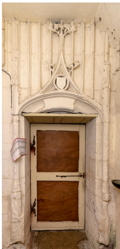
Porte d'entrée dans le chœur depuis l'ancienne sacristie. Phot. Marc Kérignard IVR32_20236000216NUCA
