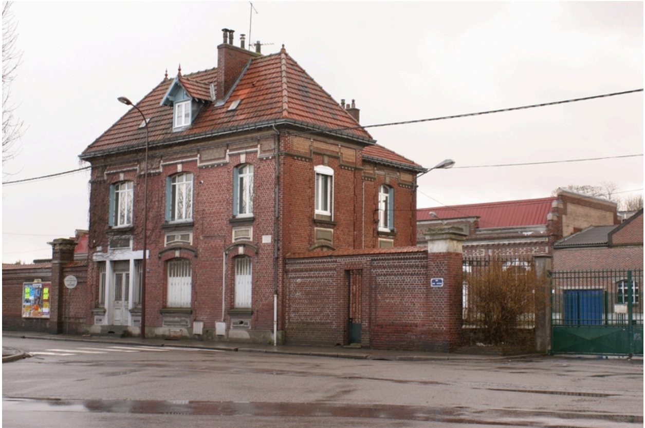
Bureaux de l'administration.
