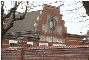
Pignon des vestiaires d'usine, côté cour.
