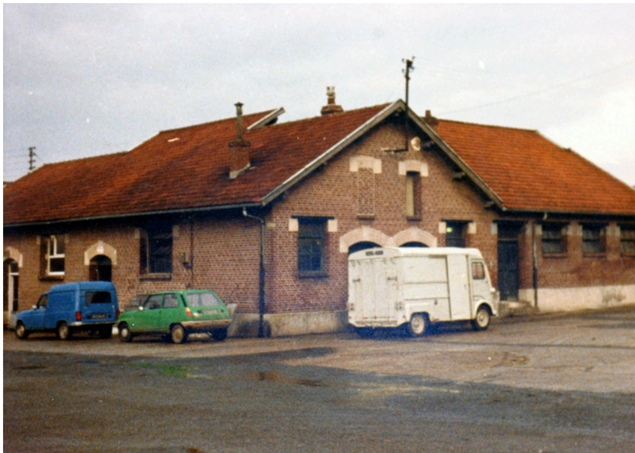
L'atelier de triperie avant démolition en 1985. Photographie Maillot, Maslard, Scalabrini (architectes).
