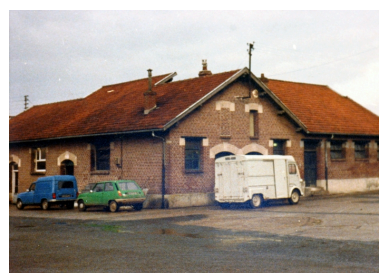
L'atelier de triperie avant démolition en 1985. Photographie Maillot, Maslard, Scalabrini (architectes). Phot. Pillet Frédéric IVR22_20050206317NUCAB
