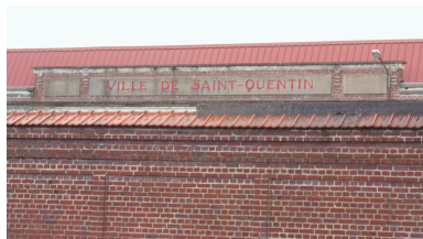
Mur de clôture (premier plan) et abattoir des bovins (arrière-plan).
