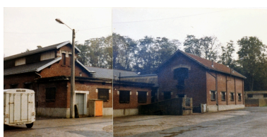
L'abattoir aux porcs, avant démolition en 1985. Photographie Maillot, Maslard, Scalabrini (architectes). Phot. Pillet Frédéric IVR22_20050206316NUCAB
