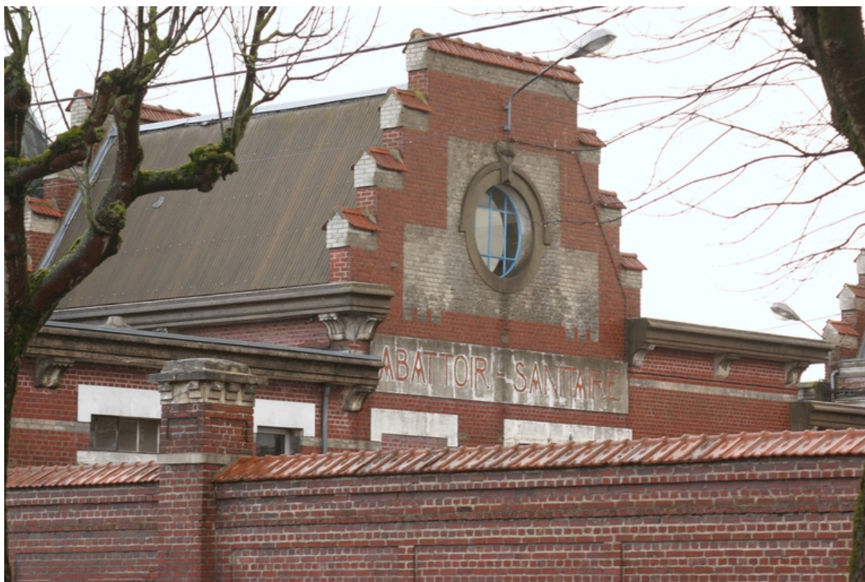
Pignon des vestiaires d'usine, côté cour.
