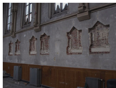
Chapelle, intérieur : traces d'arrachements du chemin de croix (nef). Phot. Bruno Decrock IVR31_20106202978NUCA
