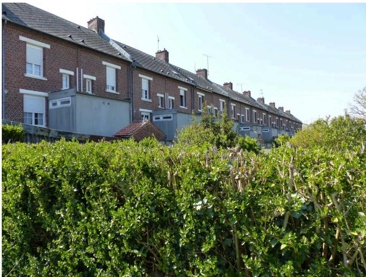
Vue des façades sur jardin.
