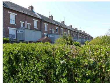
Vue des façades sur jardin. Phot. Isabelle Barbedor IVR32_20218005309NUCA
