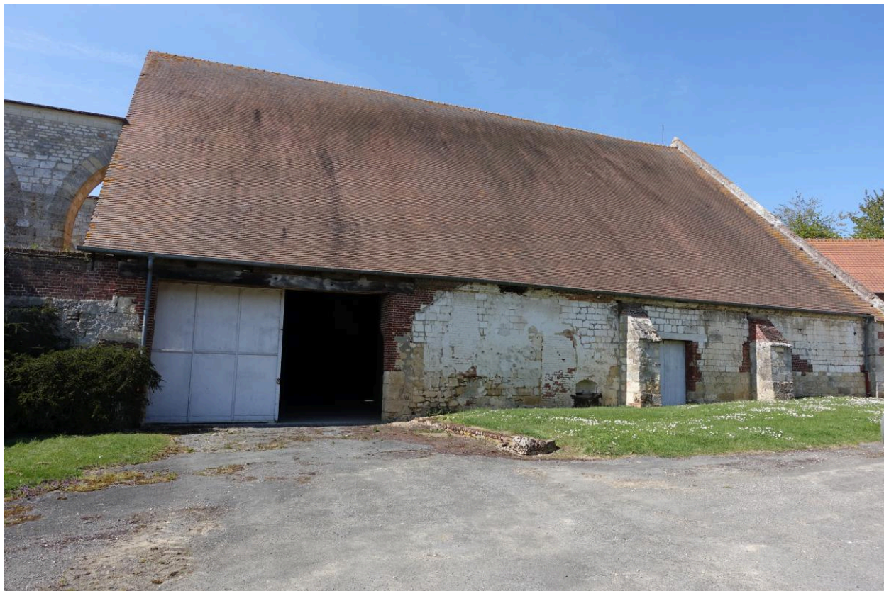
Partie est de la grange, vue depuis le sud.
