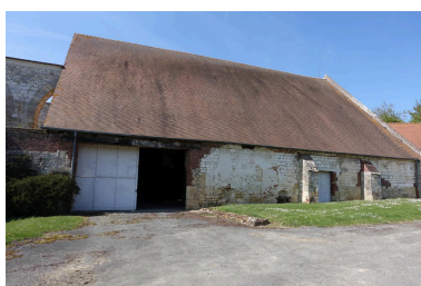
Partie est de la grange, vue depuis le sud. Phot. Lucile Chamignon IVR32_20226005080NUCA
