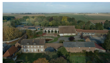
Vue aérienne de la grange médiévale depuis le jardin de la ferme côté sud. Phot. Marc Kérignard IVR32_20226001091NUCA
