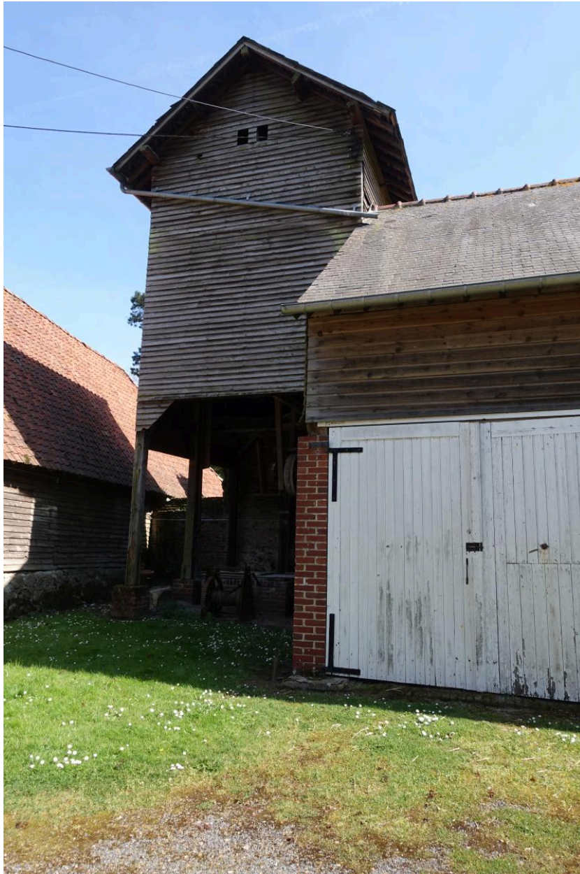
Puits surmonté d'une citerne, vue depuis le nord.
