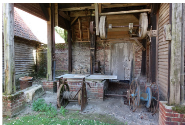
Détail du mécanisme de pompage du puits. Phot. Lucile Chamignon IVR32_20226005076NUCA
