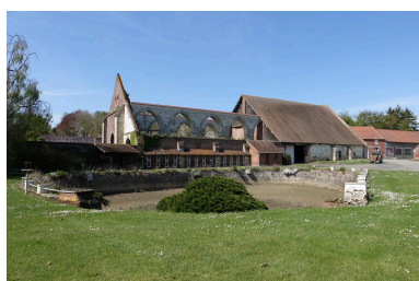
Vue générale du côté sud de la grange. Phot. Lucile Chamignon IVR32_20226005074NUCA
