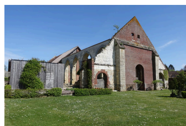
Vue générale de la grange médiévale depuis le nord-ouest. Phot. Lucile Chamignon IVR32_20226005067NUCA
