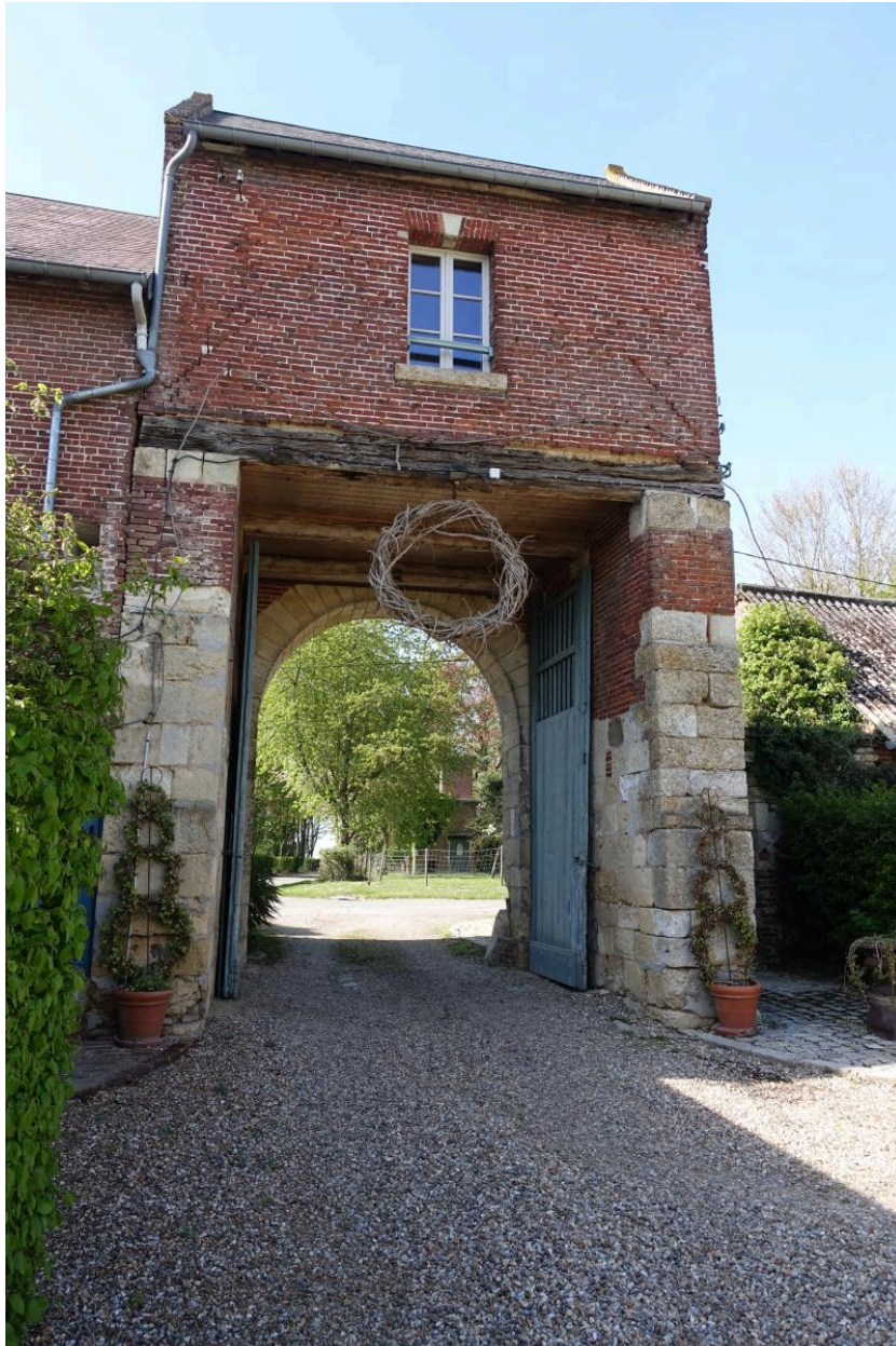
Vue générale de la porterie depuis l'intérieur de la cour (sud-est).
