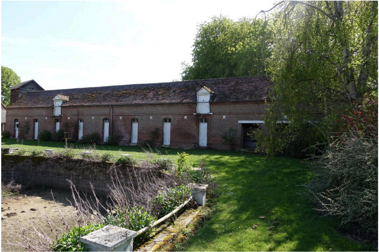
Anciennes porcheries, vue depuis le nord-est.
