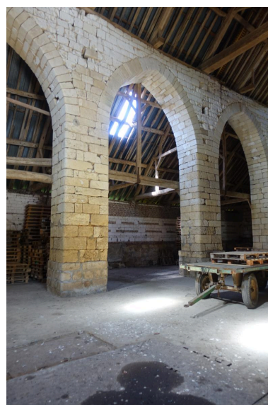
Vue intérieure de la partie est de la grange : grandes arcades. Phot. Lucile Chamignon IVR32_20226005081NUCA
