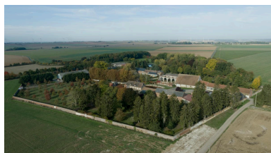
Vue aérienne de l'emprise parcellaire de la grange depuis le sud-est. Phot. Marc Kérignard IVR32_20226001089NUCA
