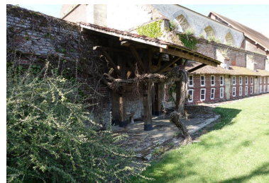
Travail à ferrer les bœufs, vue depuis le sud. Phot. Lucile Chamignon IVR32_20226005077NUCA
