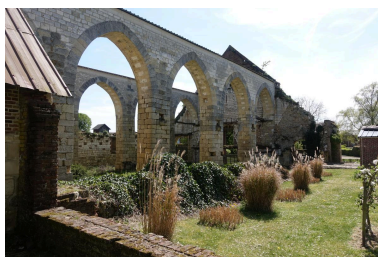
Vue de la grange depuis le nord-est. Phot. Lucile Chamignon IVR32_20226005071NUCA
