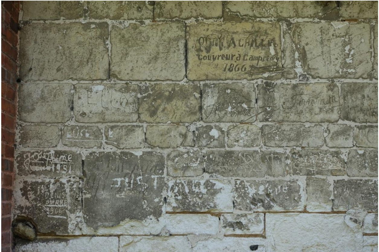
Mur nord gravé de la signature du couvreur Achille Obry.
