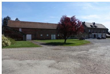
Vue générale depuis le nord des écuries et du logis de la ferme implantée au sud de la grange. Phot. Lucile Chamignon IVR32_20226005073NUCA
