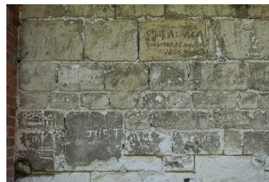
Mur nord gravé de la signature du couvreur Achille Obry. Phot. Lucile Chamignon IVR32_20226005070NUCA
