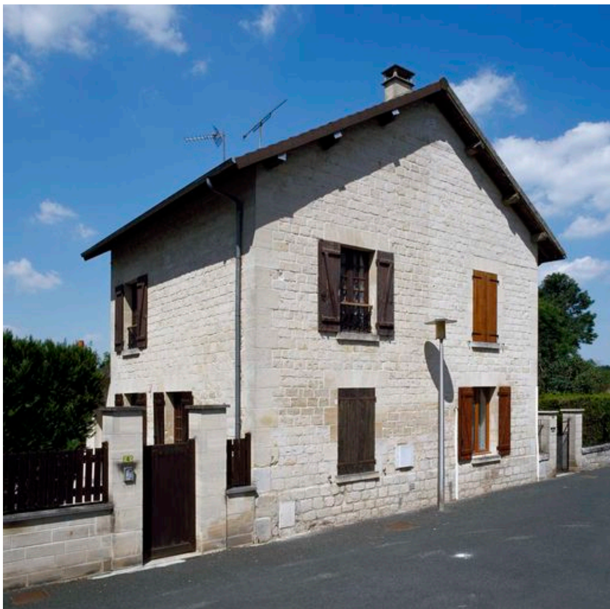
Maison ouvrière à deux unités d'habitation, quartier de l'Economat.
