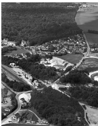
Vue aérienne vers 1995, au centre l'économat des carriers. Phot. Sanson Aviation IVR22_19956000797X
