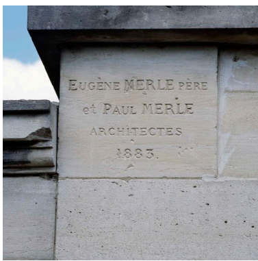
Signature des architectes Eugène et Paul Merle. Phot. Thierry Lefébure IVR22_20106000796XA
