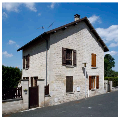
Maison ouvrière à deux unités d'habitation, quartier de l'Economat. Phot. Thierry Lefébure IVR22_20106000800XA
