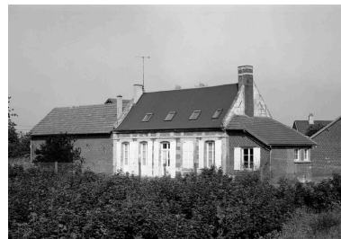
Logis. Elévation postérieure. Phot. Jean-Michel Perrin IVR22_19856000867X
