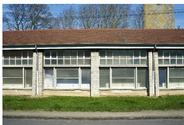
Détail de deux travées de la façade sud. Phot. Thierry Lefébure IVR32_20170200153NUC2A
