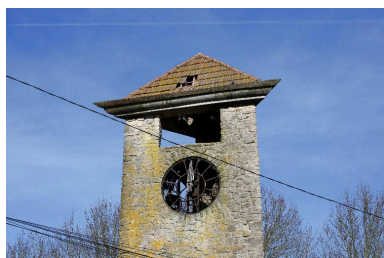
Détail de l'horloge arrêtée à l'heure du bombardement de la ville. Phot. Thierry Lefébure IVR32_20170200151NUC2A
