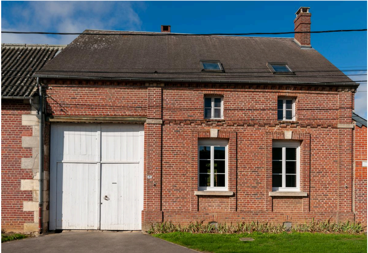
Maison de commerçant ou d'artisan (?), n°21 rue de la Mairie, vue depuis le sud-est.
