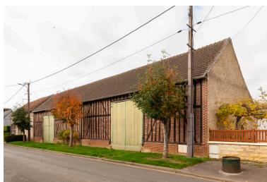
Anciennes granges, n°10 rue de la Place, vue depuis le nord-est. Phot. Marc Kérignard IVR32_20226001135NUCA
