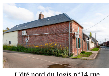
Côté nord du logis n°14 rue des Frênes, date portée "1860". Phot. Marc Kérignard
