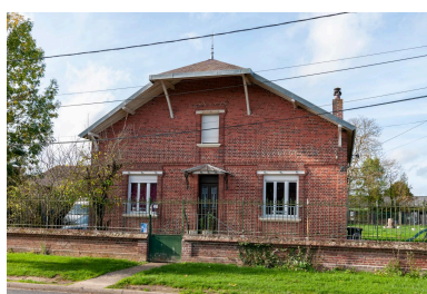
Logis en retrait de la rue, n°27 rue de la Mairie, vue depuis le sud-est.
