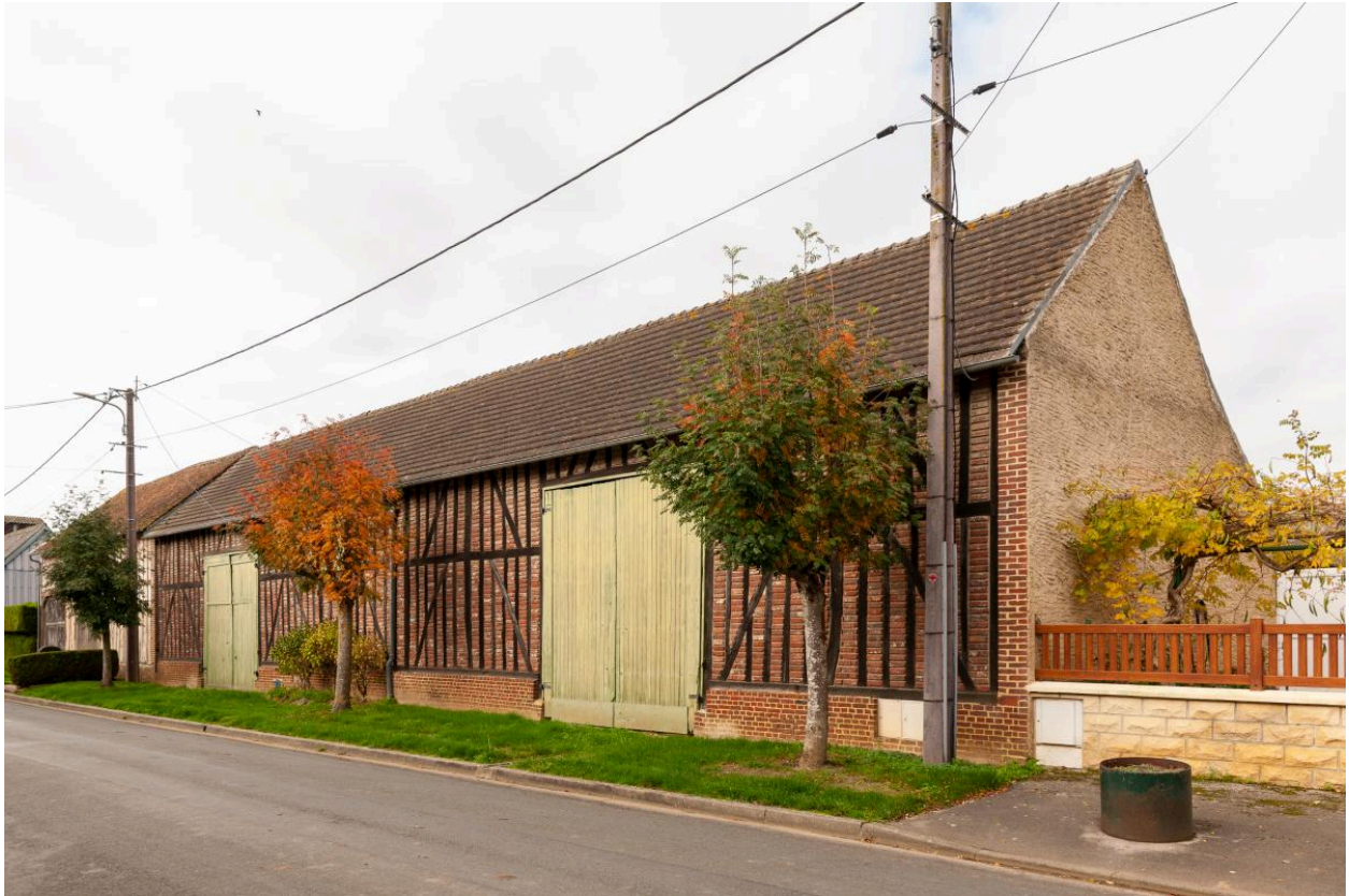
Anciennes granges, n°10 rue de la Place, vue depuis le nord-est.
