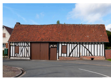
Ancienne grange avec porte à engranger et entrées charretière et piétonne, n°2 rue du Bois, vue depuis l'est. Phot. Marc Kérignard IVR32_20226001151NUCA
