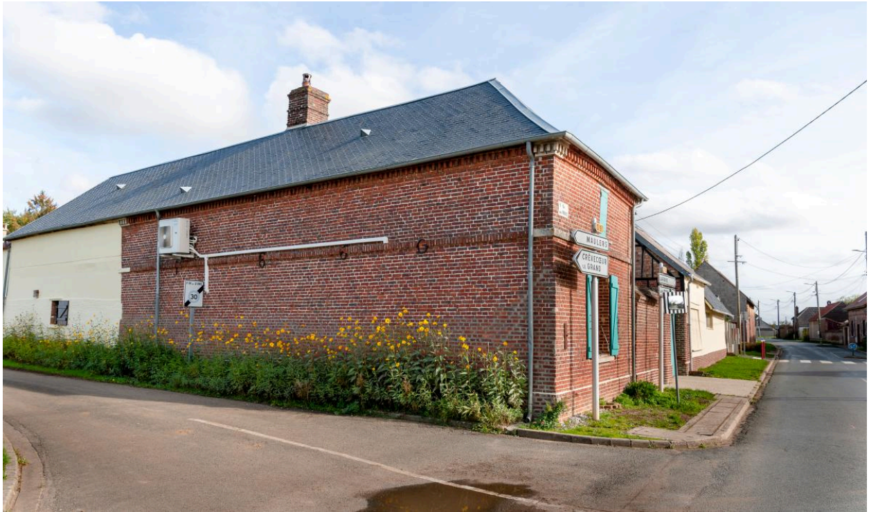
Côté nord du logis n°14 rue des Frênes, date portée "1860".
