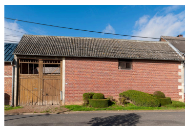
Grange reconstruite en brique, n°19 rue de la Mairie, vue depuis le sud-est. Phot. Marc Kérignard IVR32_20226001148NUCA
