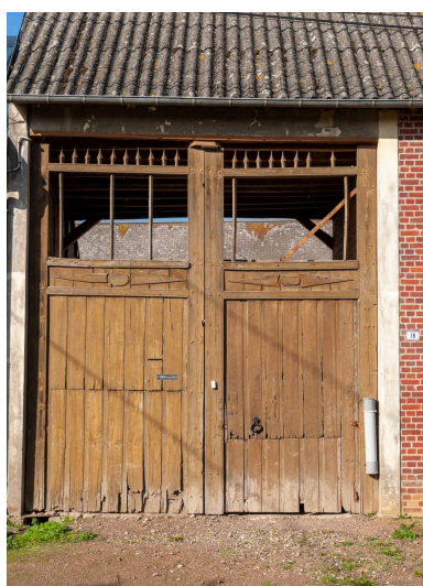
Porte charretière, n °19 rue de la Mairie. Phot. Marc Kérignard IVR32_20226001149NUCA
