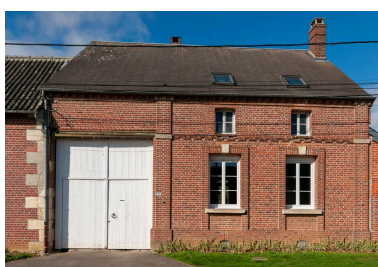
Maison de commerçant ou d'artisan (?), n°21 rue de la Mairie, vue depuis le sud-est. Phot. Marc Kérignard IVR32_20226001150NUCA
