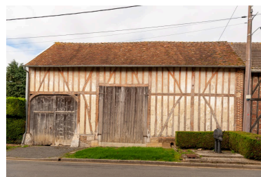
Ancienne grange avec entrée charretière, n°14 rue de la Place, vue depuis le sud-est. Phot. Marc Kérignard IVR32_20226001137NUCA
