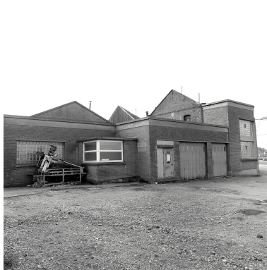
Élévation postérieure. Phot. Olivier Marlard IVR31_19895900428X
