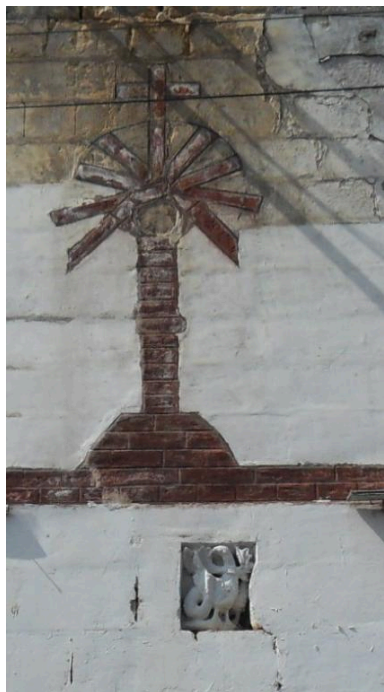
Décor du pignon en calcaire, d'une maison reconstruite, rue de Vignacourt. Phot. Isabelle Barbedor IVR22_20108010151NUCA
