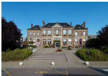
La mairie de Saint-Ouen (ancienne école de garçons). Phot. Thierry Lefébure IVR22_20128000868NUCA
