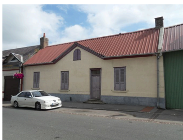
Ancien logis de ferme, reconstruit vers 1838, 11 rue Philippe- Louis (ancienne rue d'Amiens). Phot. Isabelle Barbedor IVR22_20108001534NUCA
