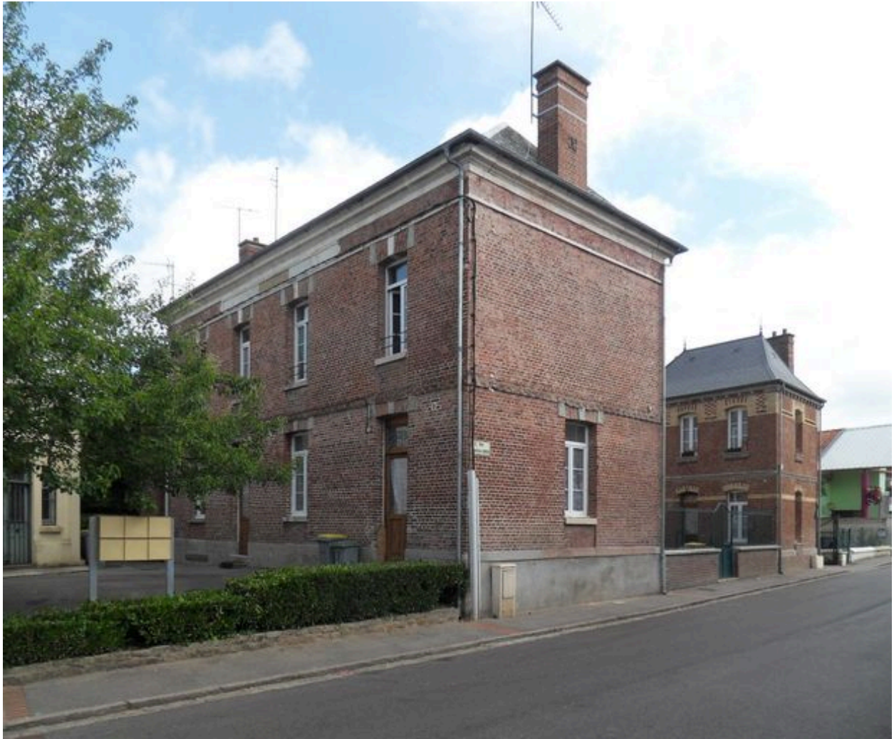
La première école de Saint-Ouen, agrandie et transformée en maison de retraite.
