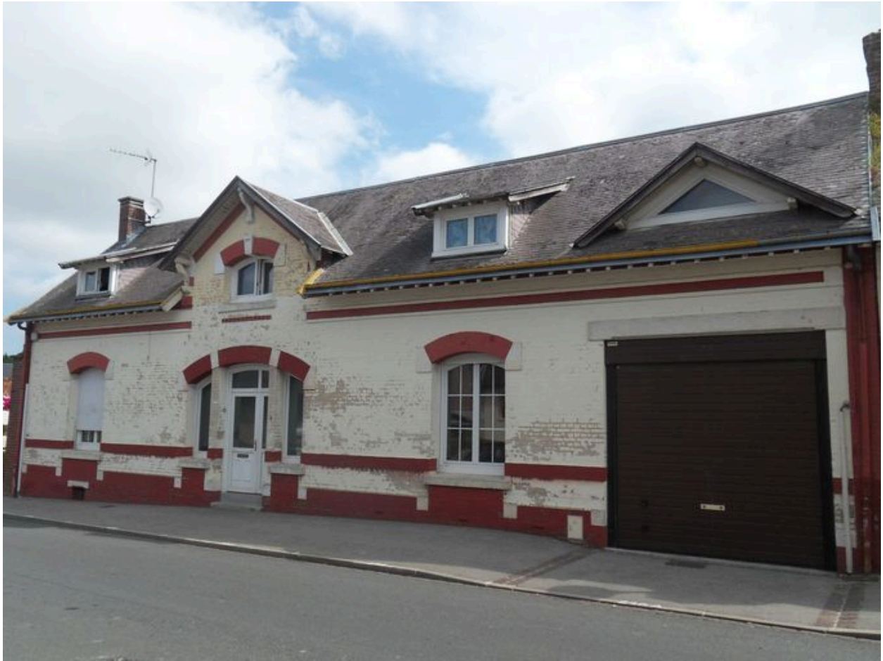
Ancien logis de ferme (?), 1er quart 20e siècle, 9 rue Philippe-Louis (ancienne rue d'Amiens).
