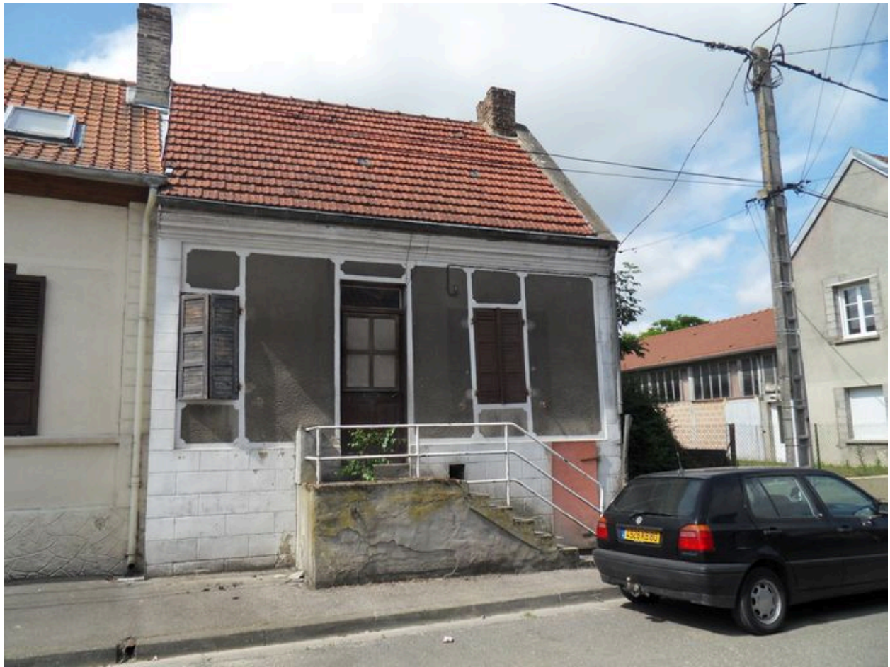
Maison de tisserand, 20 rue de Vignacourt.
