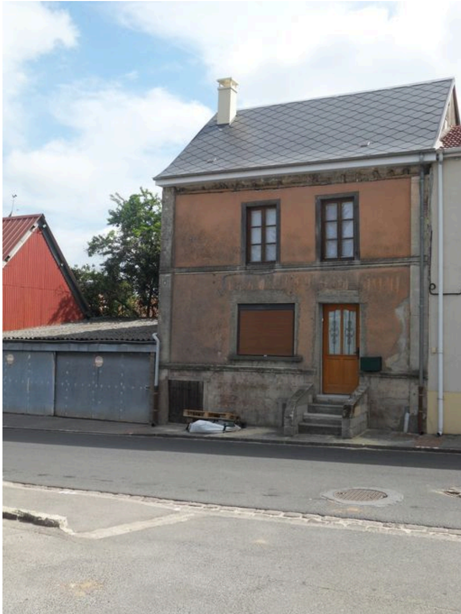
Maison à étage, construite vers 1862, 3 rue Philippe-Louis (ancienne rue d'Amiens).
