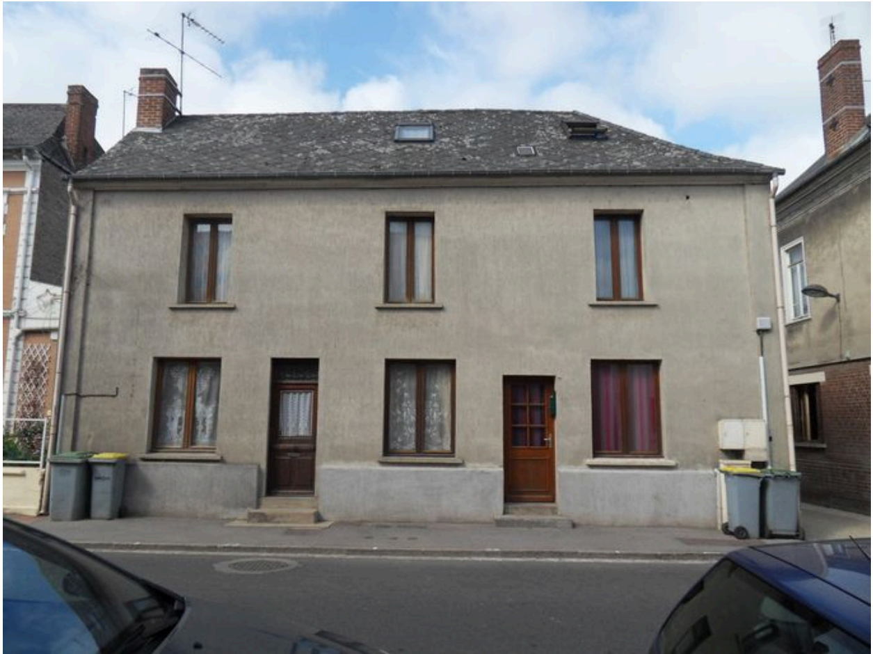
Maison à étage, à deux unités d'habitation, surélevées en 1854, 57-59 rue de la République (ancienne chaussée de Brunehaut).
