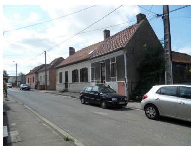
Maison, 20 à 24 rue de Vignacourt. Phot. Isabelle Barbedor IVR22_20108001544NUCA
