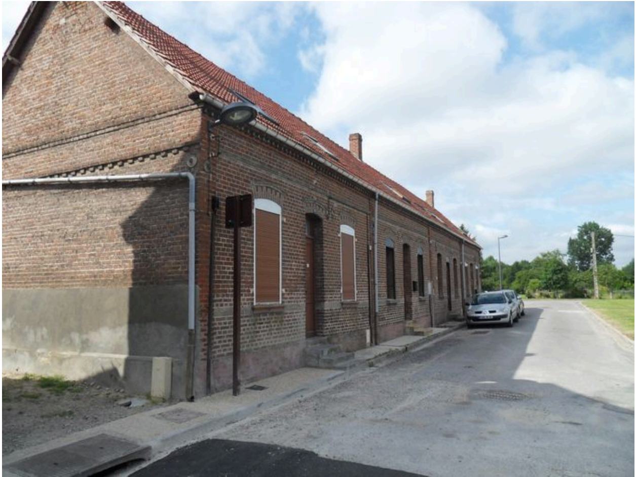
Logements, 39 à 45 rue Victor-Hugo (ancienne ruelle Blond).
