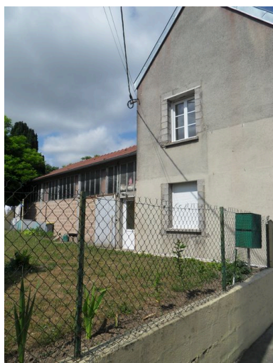
Ancienne scierie, 18 rue de Vignacourt. Phot. Isabelle Barbedor IVR22_20108001551NUCA
