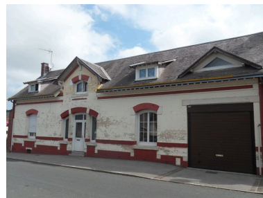
Ancien logis de ferme (?), 1er quart 20e siècle, 9 rue Philippe- Louis (ancienne rue d'Amiens). Phot. Isabelle Barbedor IVR22_20108001535NUCA
