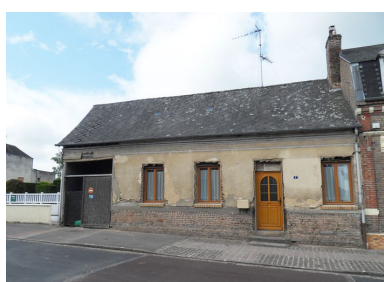
Maison, 2bis rue Philippe-Louis. Cette maison en pan de bois sur solin de brique conserve une disposition à passage traversant, visible sur le cadastre napoléonien. Phot. Isabelle Barbedor IVR22_20108001530NUCA
