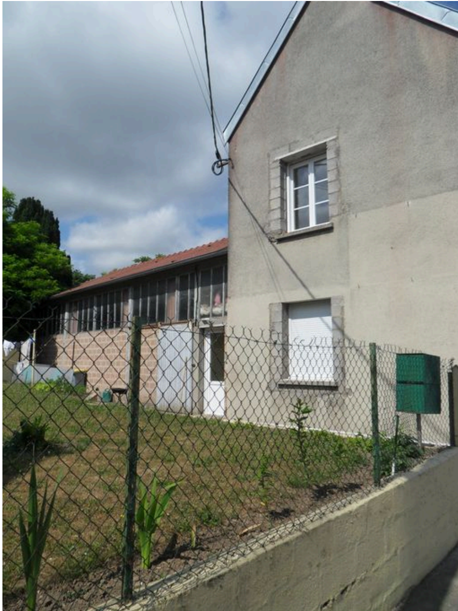
Ancienne scierie, 18 rue de Vignacourt.
