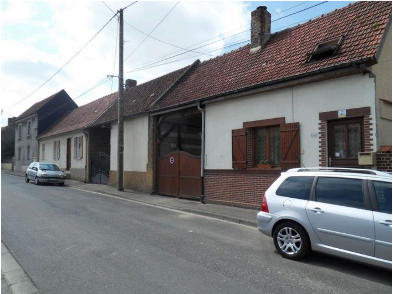
Maisons, 14 à 18 rue de Vignacourt.
