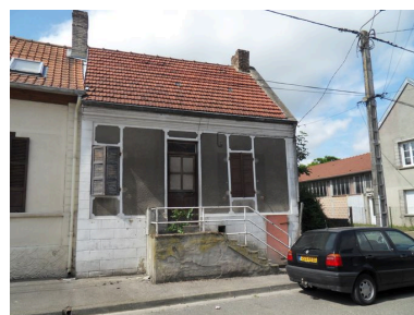
Maison de tisserand, 20 rue de Vignacourt. Phot. Isabelle Barbedor IVR22_20108001545NUCA
