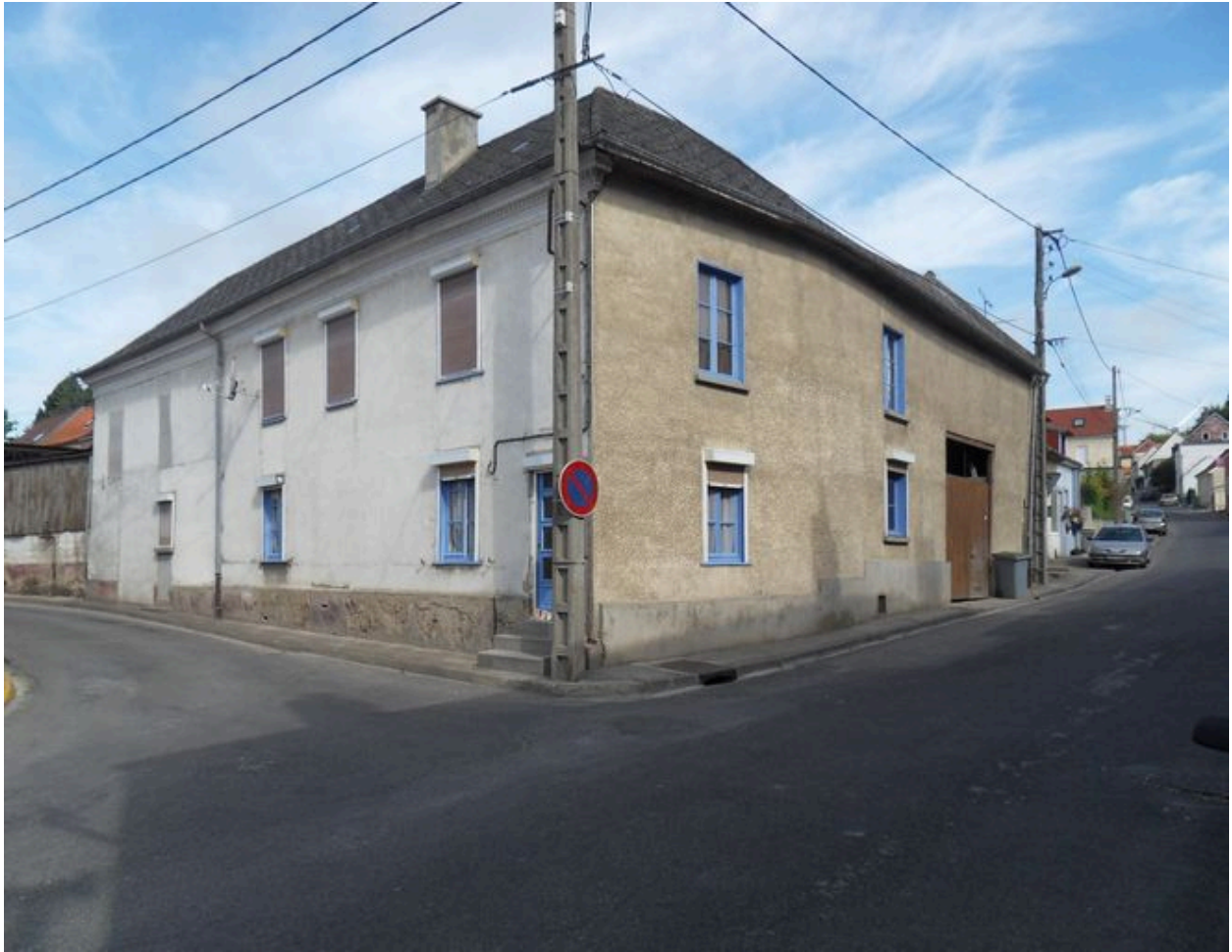
Ancienne ferme, rue de la Cense (quartier de la Cavée).
