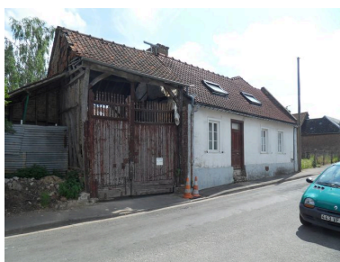
Ancienne ferme, 15 rue de Vignacourt. Phot. Isabelle Barbedor IVR22_20108001556NUCA
