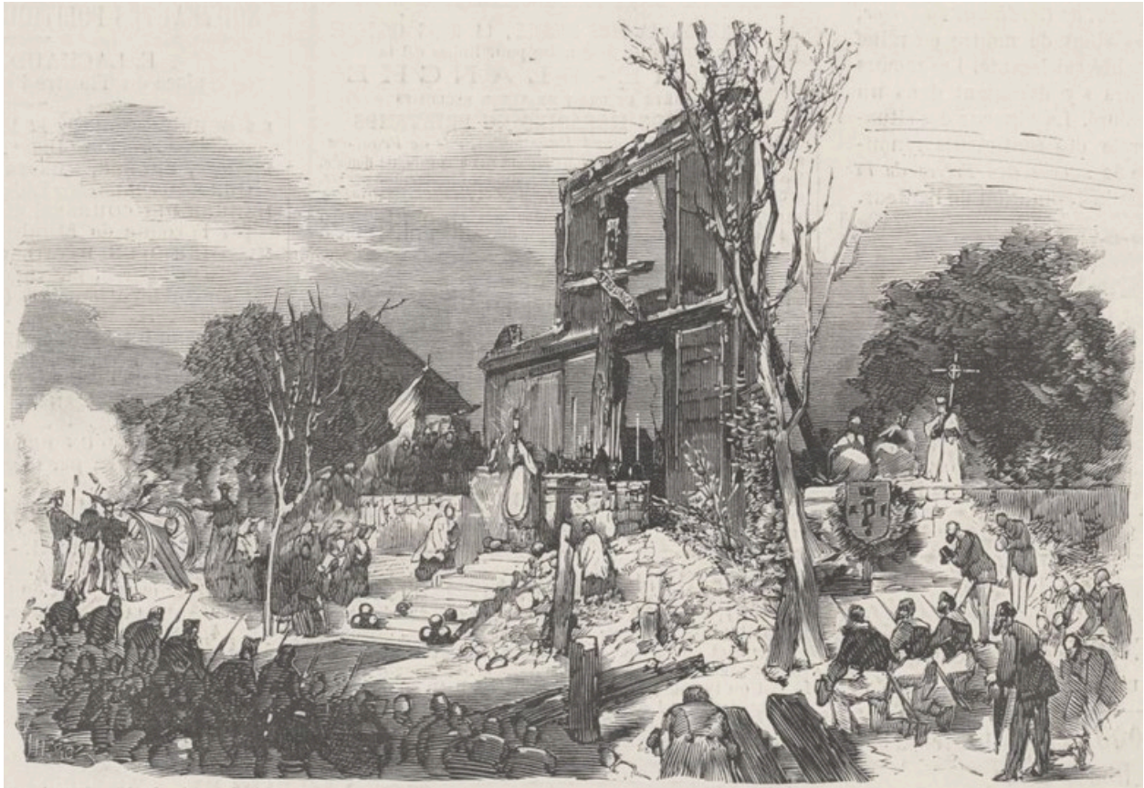
La Fête-Dieu, à Péronne. Un reposoir au milieu des ruines d'une maison de la rue Saint-Furcy, détruite pendant la dernière guerre. Extrait du Monde illustré, 1872.
