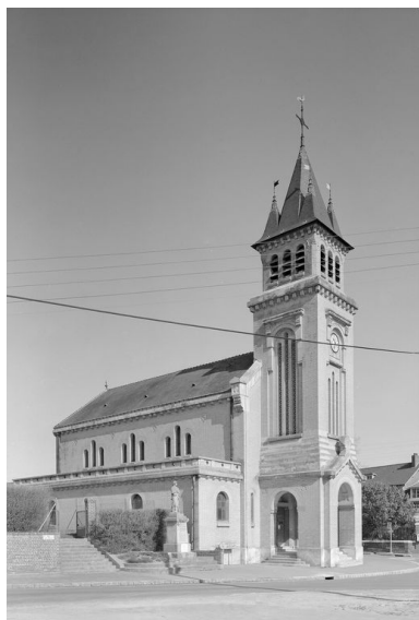
Elévation nord-ouest. Phot. Jean-Michel Perrin IVR22_19856000549X
