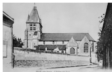
Élévation sud avant 1914 (AP). Phot. Jean-Michel Périn IVR22_19856000255XB
