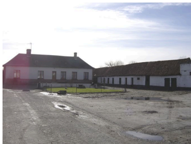
Vue du logis et des étables à cochons. Phot. Inès Guérin IVR22_20078005381NUCA
