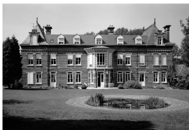
Vue générale de la façade postérieure. Phot. Irwin Leullier IVR22_19988000482X
