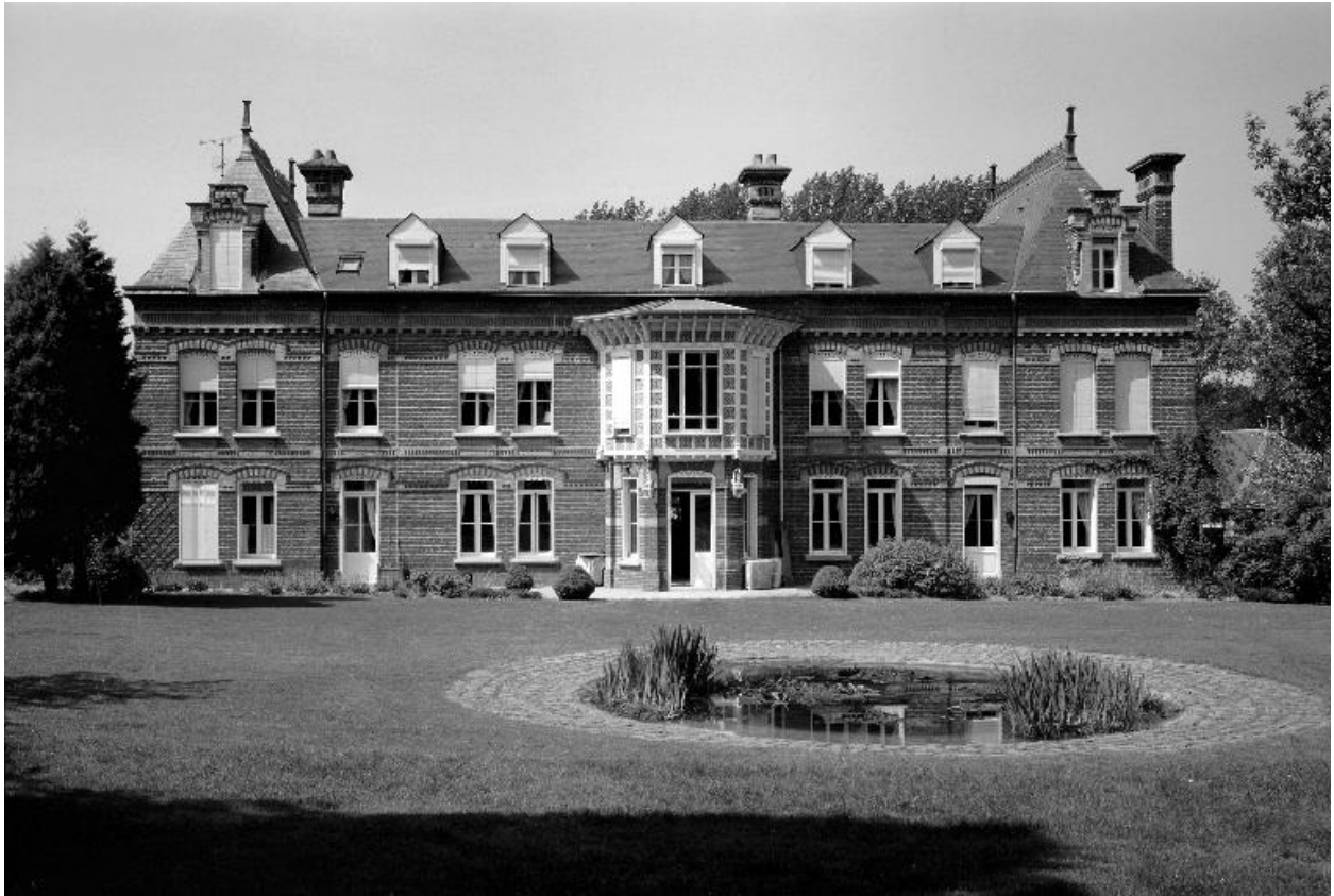
Vue générale de la façade postérieure.
