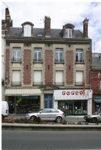
Façade antérieure, rue d'Isle. Phot. Frédéric Pillet IVR22_20050206161NUCA
