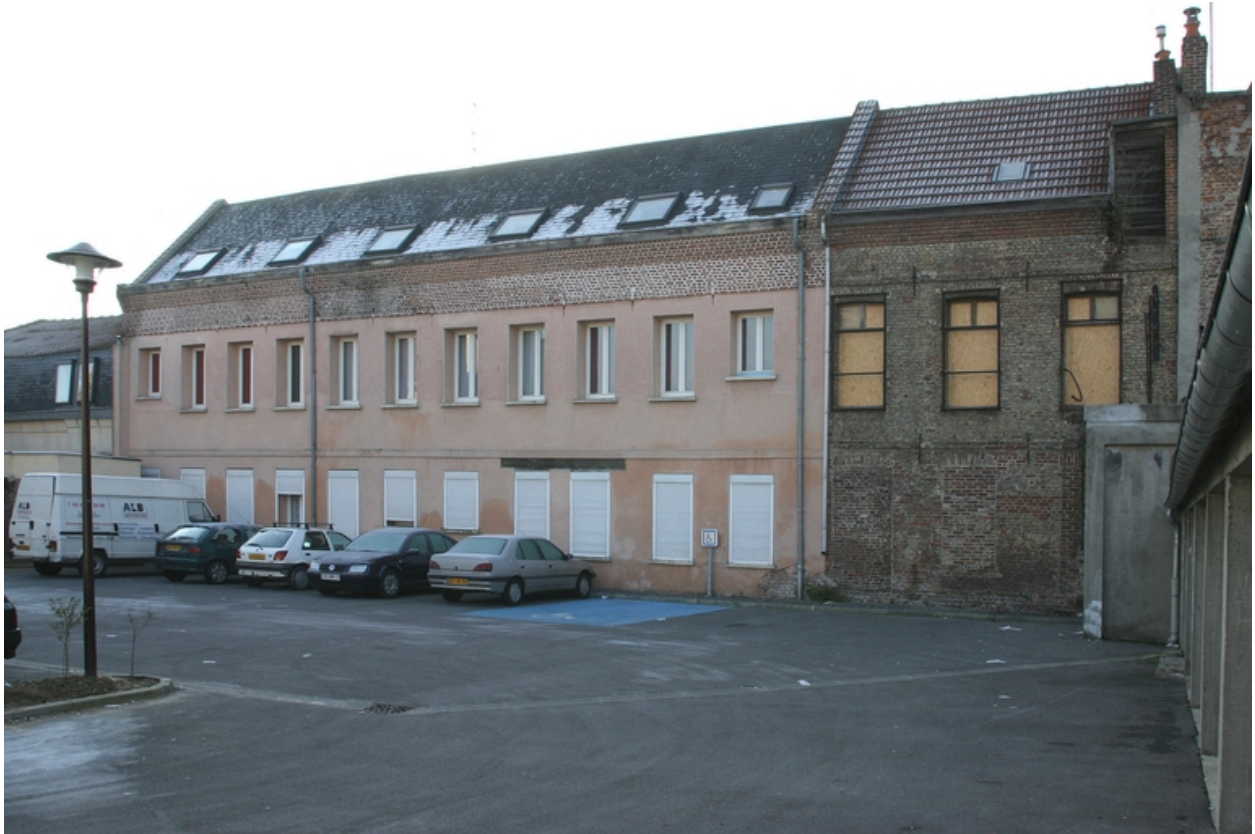
Façade postérieure des anciens ateliers, rue des Cordeliers. Au premier plan, le parking où se dressaient les ateliers détruits au début des années 2000.
