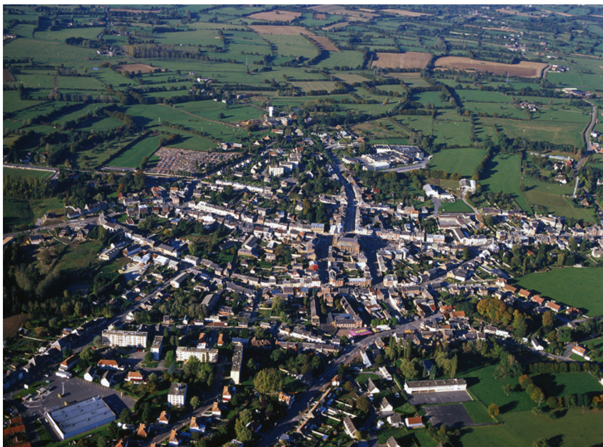
Le Nouvion-en-Thiérache. Vue aérienne.
