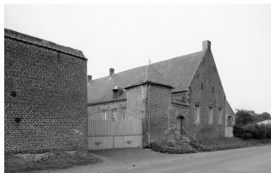
Vue d'ensemble des élévations sud, sur rue. Phot. Thierry Lefébure IVR22_19920201294Z
