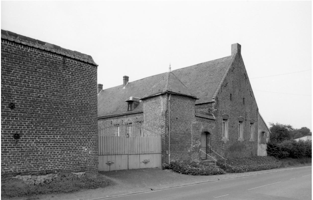
Vue d'ensemble des élévations sud, sur rue.
