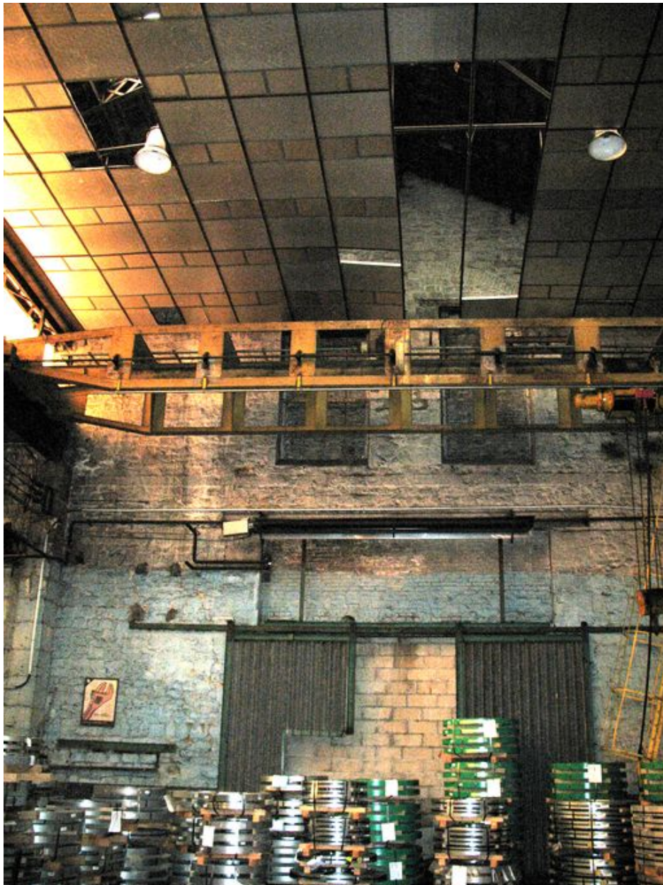
Elévation intérieure du mur pignon de la fonderie.
