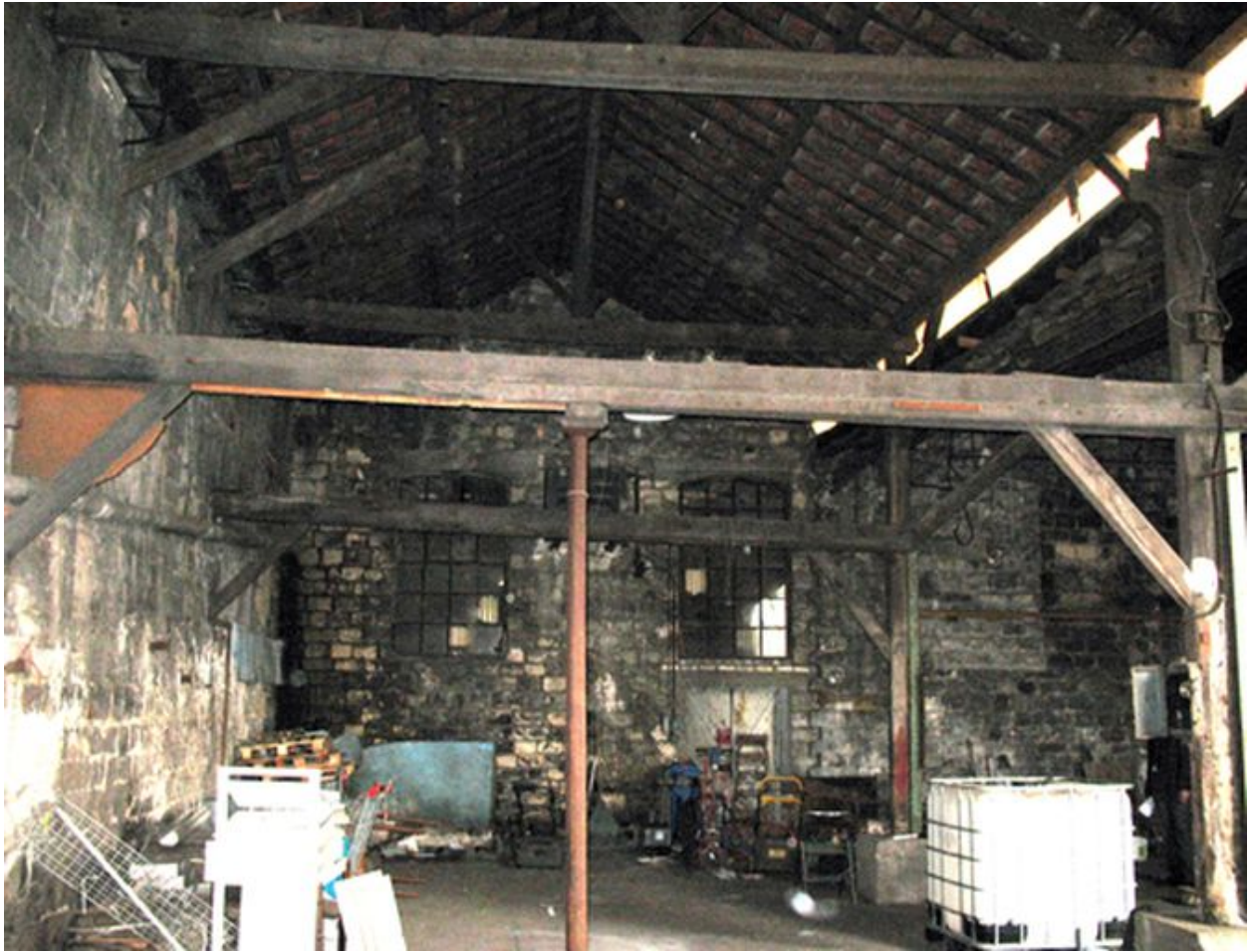
Intérieur des ateliers de fabrication construits le long de la rue des Usines.
