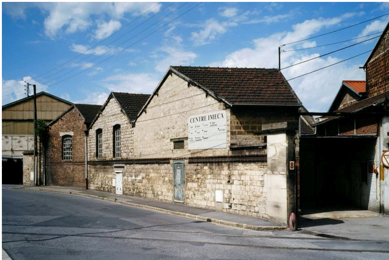
Façade des bâtiments rue des Usines depuis l'est.
