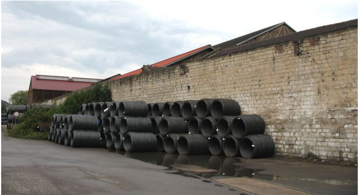
Mur de clôture de la fonderie.
