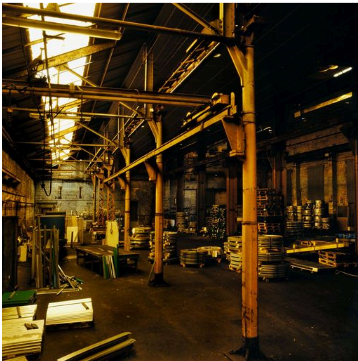
Enfilade des colonnes en fonte.
