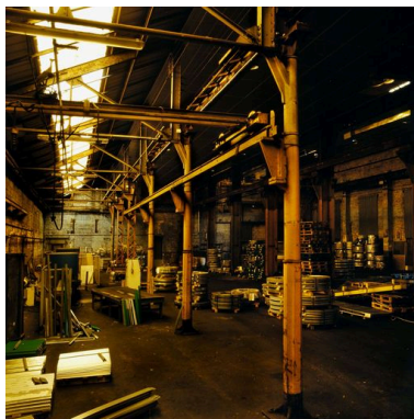
Enfilade des colonnes en fonte.
