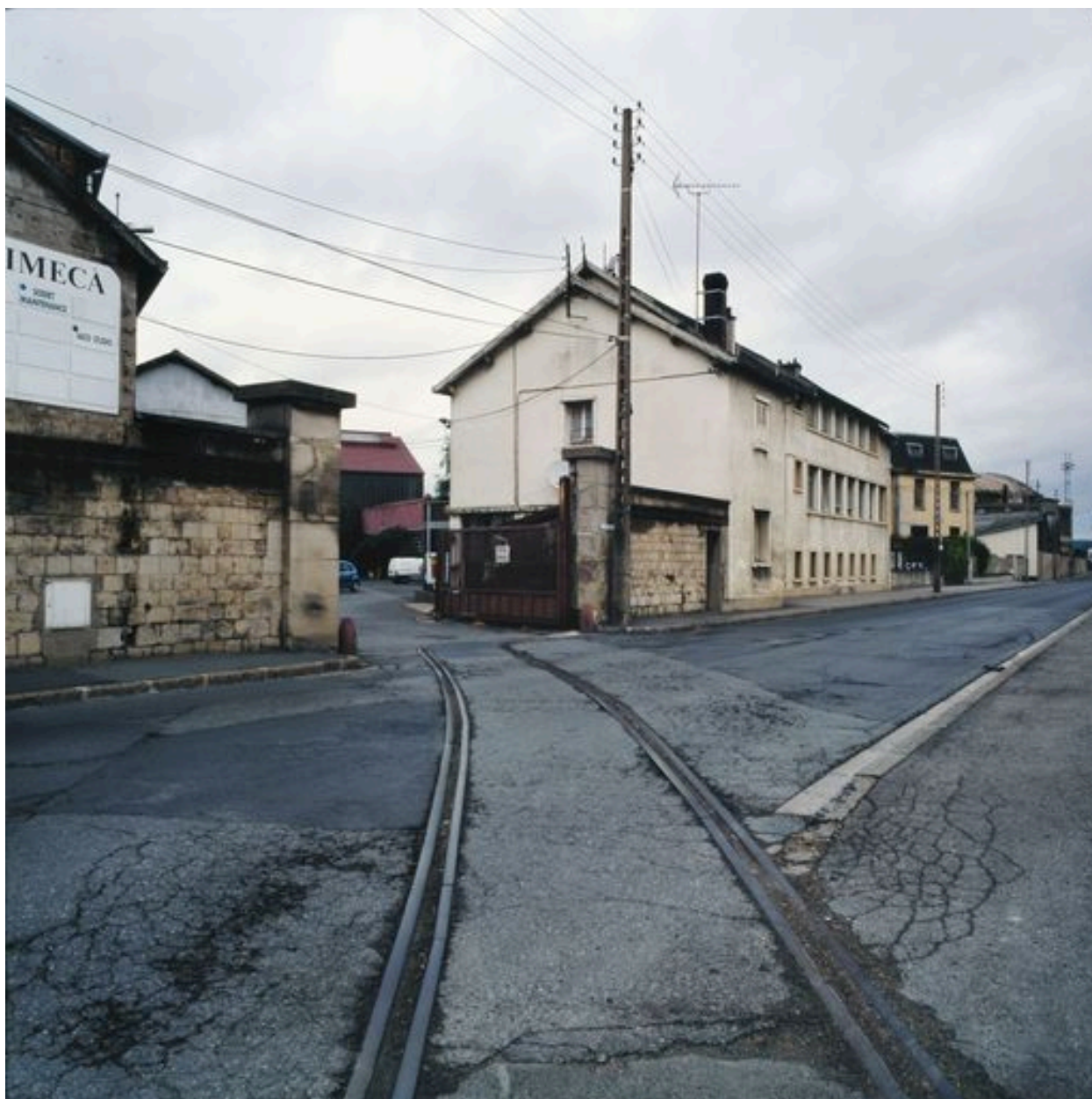
Embranchement depuis la rue des Usines.
