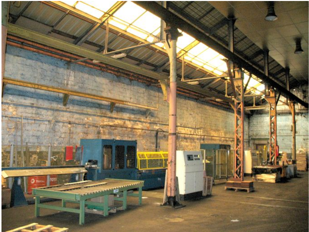
Deux travées de l'usine avec ses colonnes en fonte datées de 1898.
