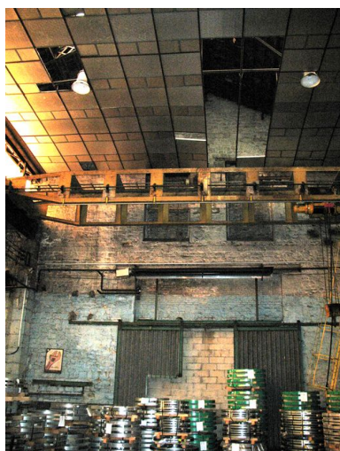
Élévation intérieure du mur pignon de la fonderie. Phot. Clarisse Lorieux IVR22_20066005134NUCA
