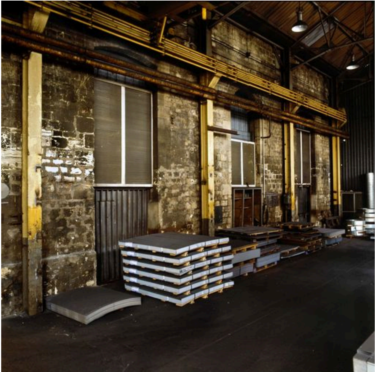
Ancien mur extérieur de la fonderie.
