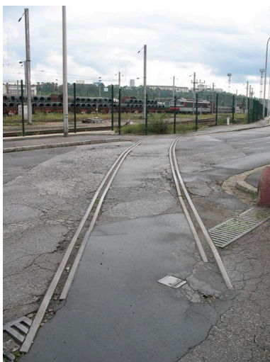
Les rails à l'entrée de l'usine. Phot. Clarisse Lorieux IVR22_20066005129NUCA
