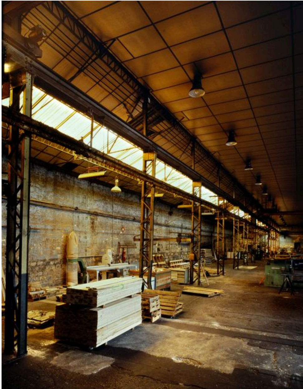
Structure métallique installée en remplacement des colonnes en fonte.
