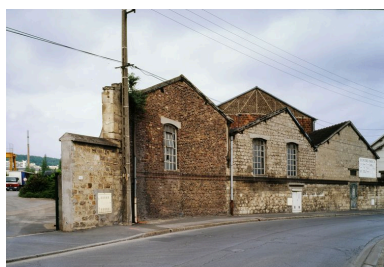
Façade des ateliers sur la rue des Usines. Phot. Thierry Lefébure IVR22_20076000043XA
