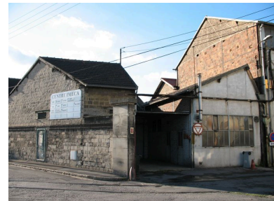
Entrée de l'ancienne fonderie Durand et desserte ferroviaire. Phot. Clarisse Lorieux IVR22_20066005127NUCA
