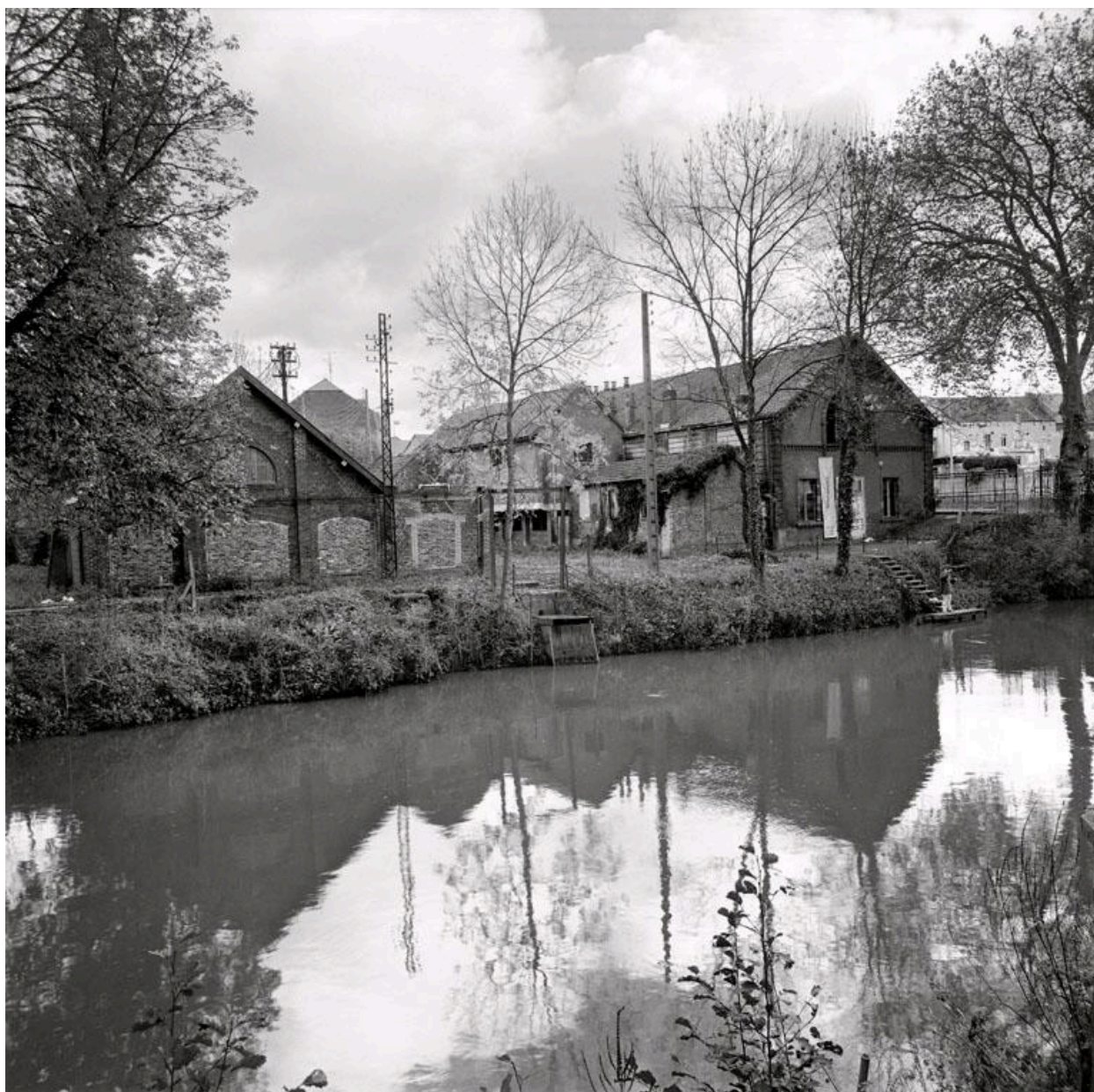
Vue générale, depuis l'Oise, des bâtiments.
