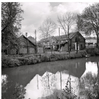
Vue générale, depuis l'Oise, des bâtiments.
