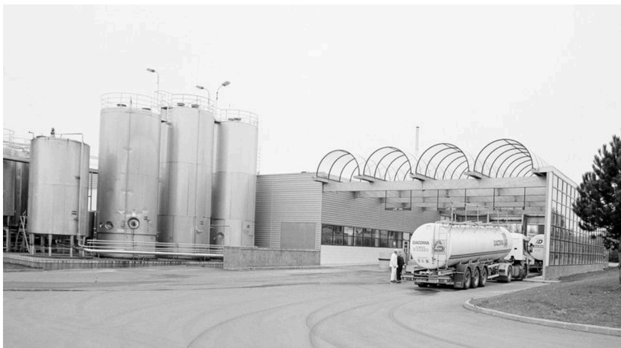
Réservoirs industriels et et bâtiment de réception du lait, dit hall de dépotage, par l'agence Arval à Crépy-en-Valois, 1989-1990.
