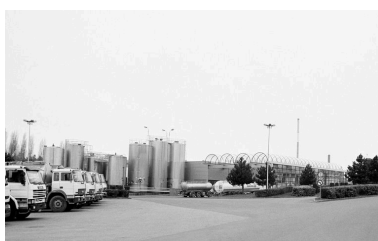
Vuë générale du bâtiment de réception du lait, dit hall de dépotage et des réservoirs industriels de stockage de lait depuis le stationnement des camions de ramassage. Phot. Bertrand Fournier IVR22_20006000252Z
