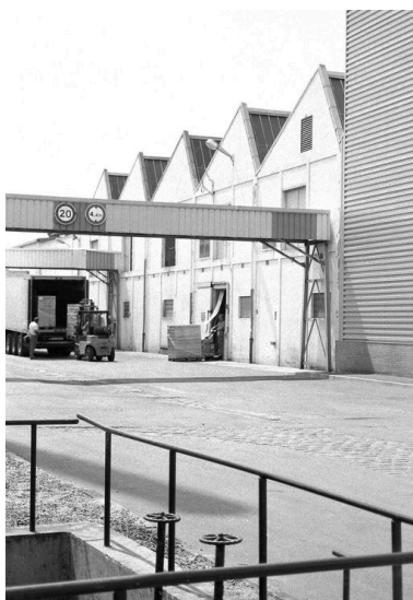
Ateliers de fabrication. Phot. Benoît Dufournier IVR22_19936001677Z
