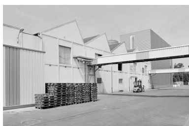
Ateliers de fabrication. Phot. Benoît Dufournier IVR22_19936001673Z
