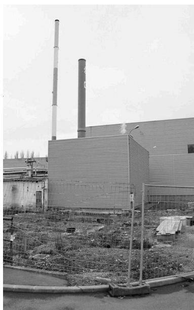
Chaufferie au gaz avec sa cheminée construite en 1996. Phot. Bertrand Fournier IVR22_20006000257Z
