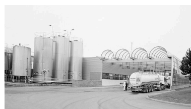
Réservoirs industriels et et bâtiment de réception du lait, dit hall de dépotage, par l'agence Arval à Crépy-en-Valois, 1989-1990. Phot. Bertrand Fournier IVR22_20006000255Z
