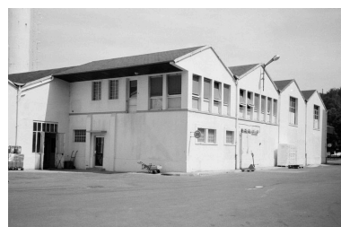
Ateliers de fabrication. Phot. Benoît Dufournier IVR22_19936001678Z
