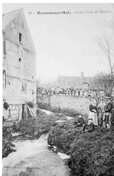
Vue du moulin sur le Matz, partiellement détruit en 1918 (AP). Phot. Bertrand Fournier IVR22_20006000051ZB
