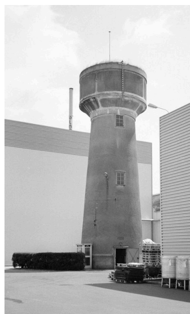
Château d'eau. Phot. Benoît Dufournier IVR22_19936001680Z
