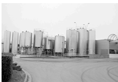
Réservoirs industriels pour le stockage du lait avant traitement de pasteurisation. Phot. Thierry Lefébure IVR22_20006000256Z
