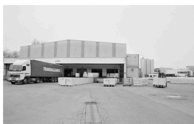
Quai de chargement des palettes de lait UHT. Phot. Bertrand Fournier IVR22_20006000251Z
