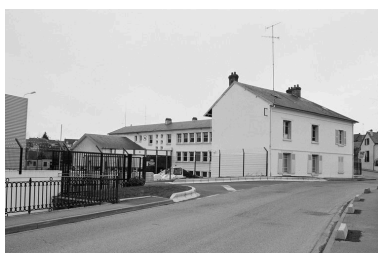
Ancienne conciergerie et bâtiment administratif avec au premier plan, le pont et les vannes de la dérivation du Matz. Phot. Bertrand Fournier IVR22_20006000259Z
