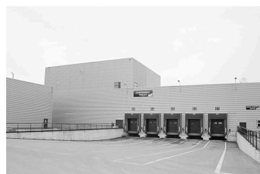
Magasin d'expédition : façade sur quai. Phot. Bertrand Fournier IVR22_20006000258Z
