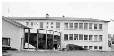
Bureaux : façade sur cour. Phot. Bertrand Fournier IVR22_20006000260Z
