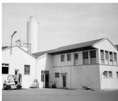
Ateliers de fabrication. Phot. Benoît Dufournier IVR22_19936001679Z
