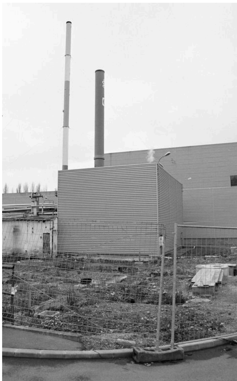
Chaufferie au gaz avec sa cheminée construite en 1996.
