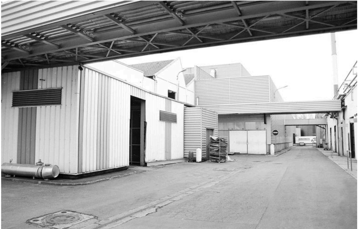
Ateliers de fabrication de yaourts dotés de sheds partiellement masqués par l'essentage métallique.
