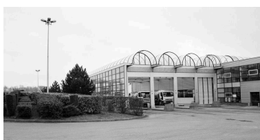
Bâtiment de réception du lait, dit hall de dépotage, construit en 1989-1990 par l'agence d'architecture Arval à Crépy-en-Valois. Phot. Bertrand Fournier IVR22_20006000253Z
