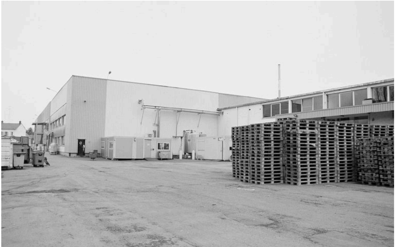
Magasin de stockage de lait UHT (partie Candia) et aire de stockage des palettes.
