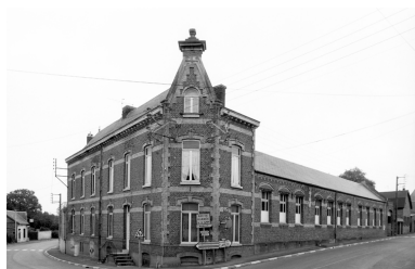
Vue d'ensemble depuis le nord-est. Phot. Thierry Lefébure IVR22_19920201295Z
