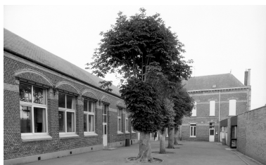
Vue d'ensemble des élévations sur cour. Phot. Thierry Lefébure IVR22_19920201298Z
