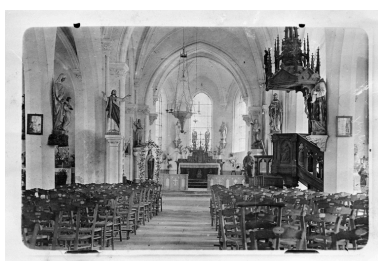
Vue intérieure de l'église vers 1930 (collection particulière). Phot. Thierry Lefébure IVR22_19910201440X
