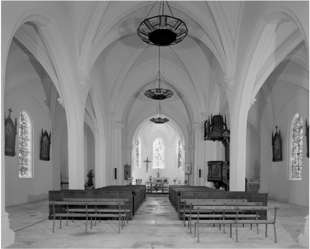
Vue intérieure depuis l'entrée vers le chœur.
