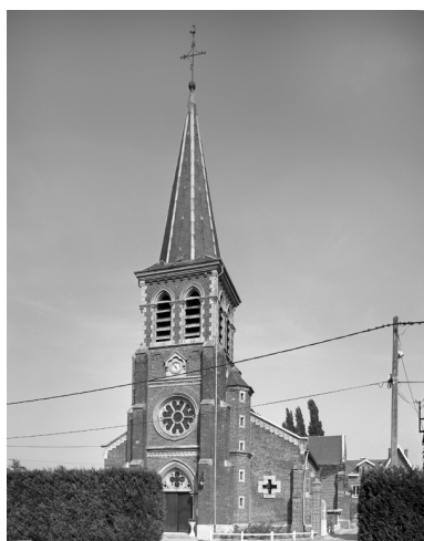
Vue d'ensemble de la façade. Phot. Thierry Lefébure IVR22_19910201429V
