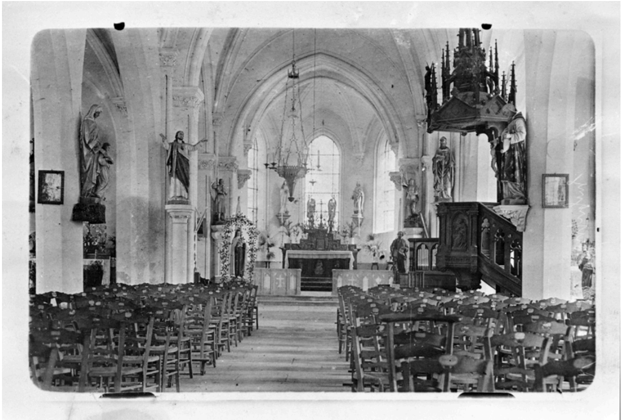
Vue intérieure de l'église vers 1930 (collection particulière).
