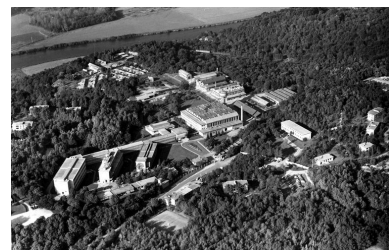
Vue aérienne du site, vers 1960 (archives d'entreprise). Phot. Clarisse Lorieux IVR22_20106003046NUCAB
