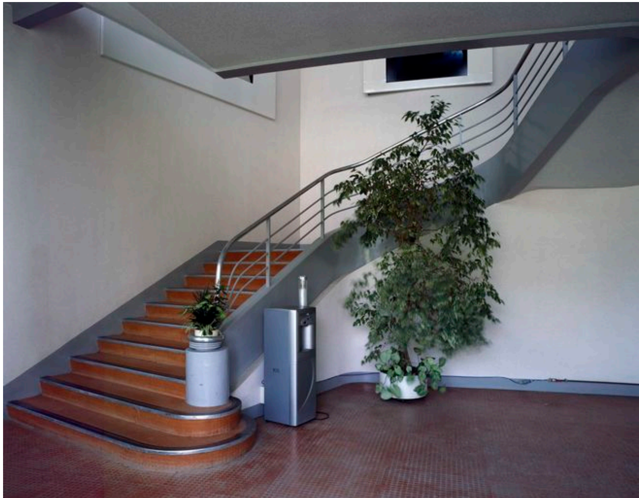
Cage et rampe d'escalier.
