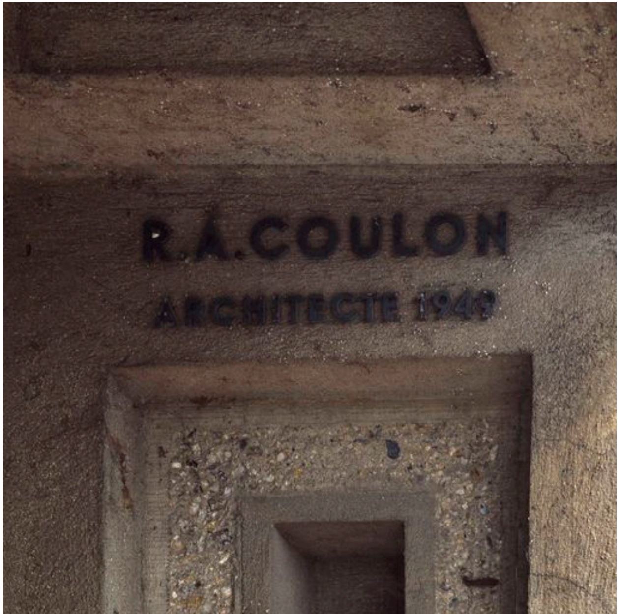
Détail de l'entrée : signature de l'architecte René-André Coulon et date (1949).
