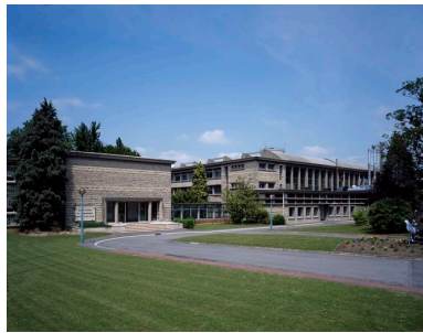
Vue générale de l'ancien bâtiment d'accueil et des laboratoires du Cerchar, aujourd'hui Ineris. Phot. Thierry Lefébure IVR22_20106000443VA
