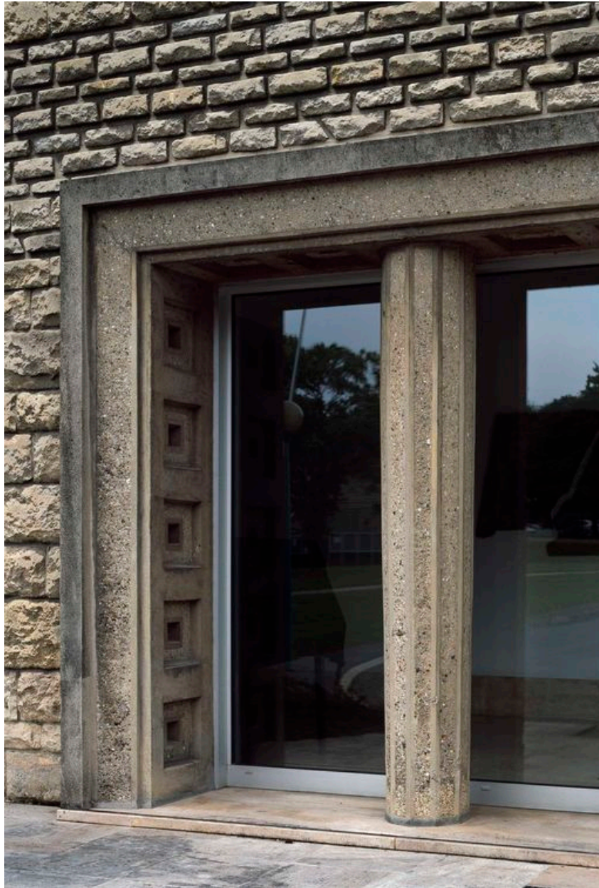
Détail de la façade d'entrée : pilier évasé.
