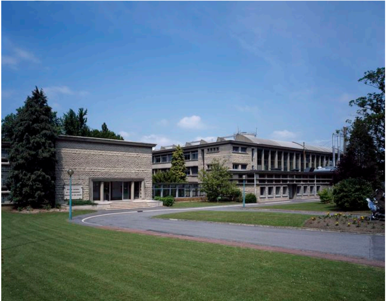
Vue générale de l'ancien bâtiment d'accueil et des laboratoires du Cerchar, aujourd'hui Ineris.
