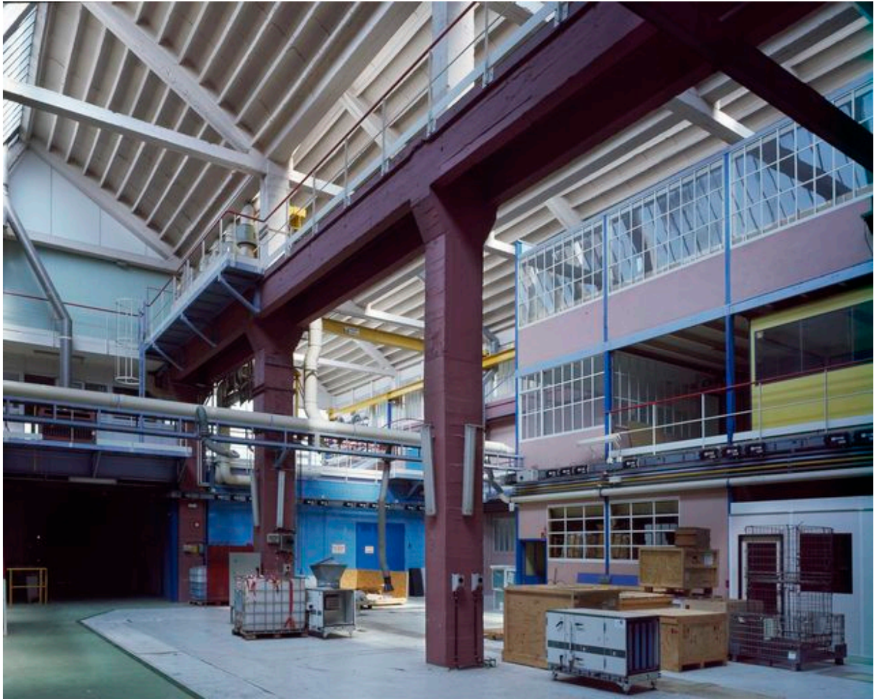
Intérieur du bâtiment dit demi-grand.
