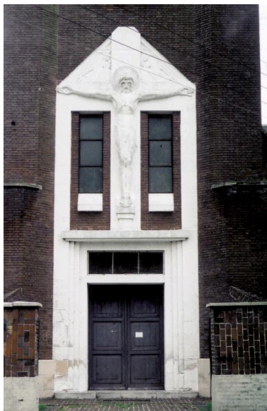
Détail du portail. Phot. Gilles-Henri Bailly IVR22_20158005521NUCA
