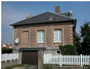
Élévation latérale droite. Phot. Elisabeth Justome IVR22_20058003098NUCA
