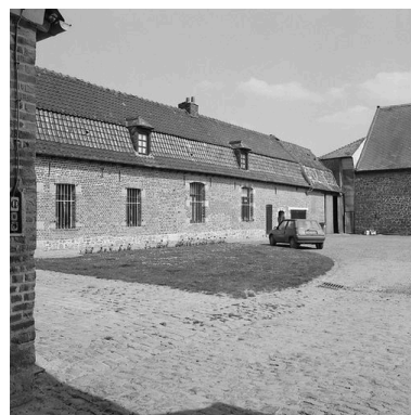
Vue générale du logis, élévation antérieure. Phot. Philippe Dapvril IVR31_20045900186X
