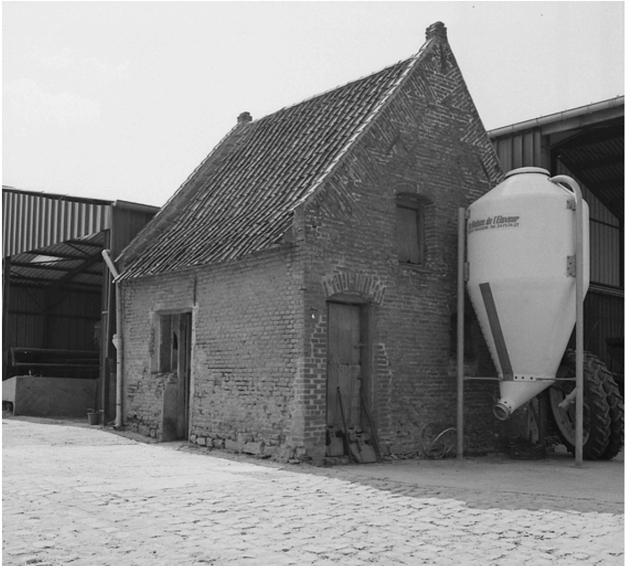
Vue générale du fournil.
