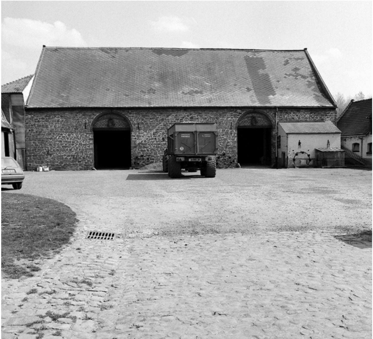
Vue générale de la grange.
