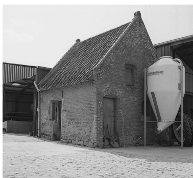
Vue générale du fournil. Phot. Philippe Dapvril IVR31_20045900185X
