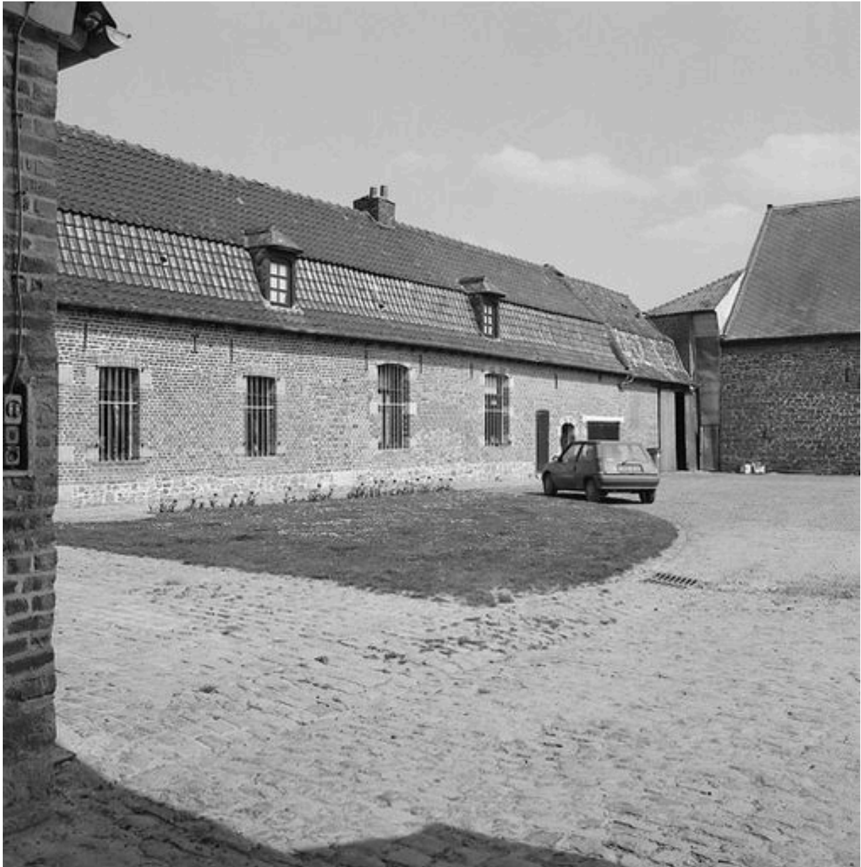
Vue générale du logis, élévation antérieure.
