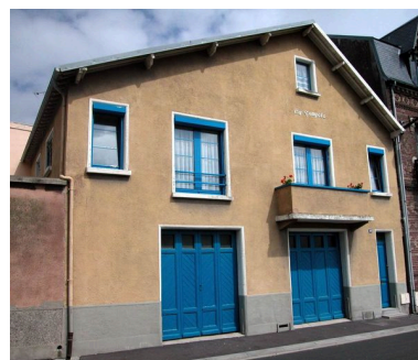
Maison dite La Tempête, 19 rue Paul-Viguer. Phot. Elisabeth Justome IVR22_20058003158NUCA
