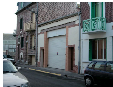
Garage, 20 rue Faidherbe (1982 AE 467). Phot. Elisabeth Justome IVR22_20058003441NUCA
