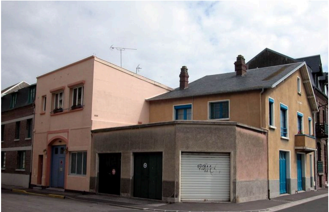
Constructions angle des rues Paul-Vigui r et Faidherbe.
