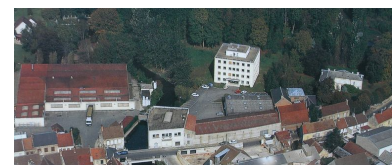
Vue aérienne de l'usine de peinture J.M. Paillard avant destruction. Phot. Fournier Bertrand (reproduction) IVR22_20046003027NUCAB
