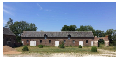
Vue des étables, à l'ouest de la cour. Phot. Isabelle Barbedor IVR32_20188005084NUCA
