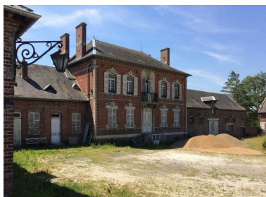
Vue du logis depuis l'entrée de la cour. Phot. Isabelle Barbedor IVR32_20188005083NUCA
