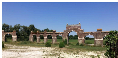
Vue de la clôture au sud de la cour. Phot. Isabelle Barbedor IVR32_20188005085NUCA
