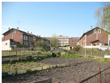
Vue générale de la cité ouvrière ouvrière Mertian à Montataire.
