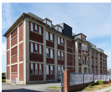
Vue du bâtiment principal, reconstruit en 1926. Phot. Isabelle Barbedor IVR32_20218005181NUCA
