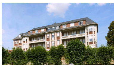
Vue de détail sur les terrasses. Phot. Thierry Lefébure IVR32_20218000255NUCA
