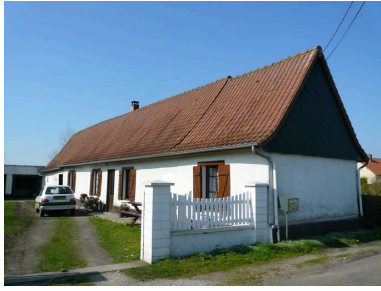
Vue générale. Phot. Inès Guérin IVR22_20078005500NUCA
