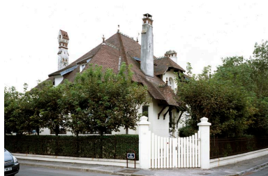
Vue générale. Phot. Philippe Dapvril IVR31_20076200053XA
