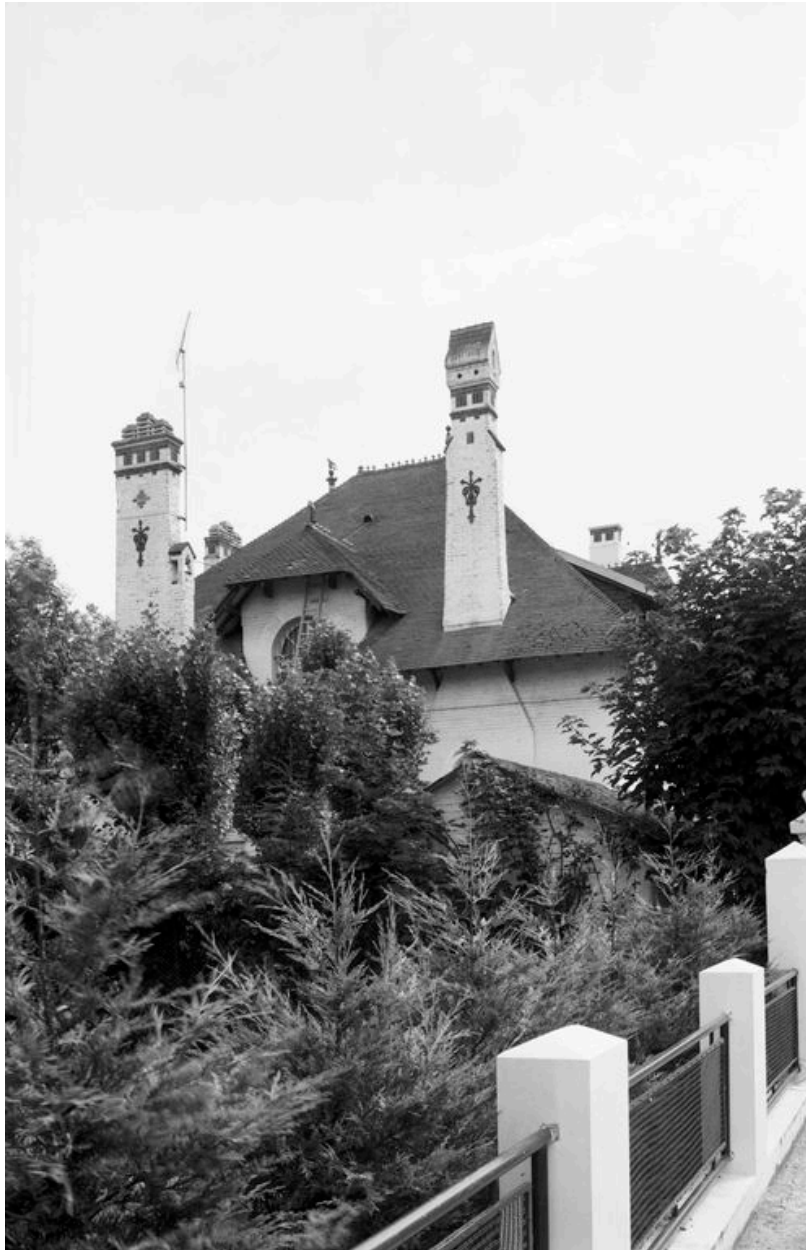
Vue générale postérieure, en 1981.
