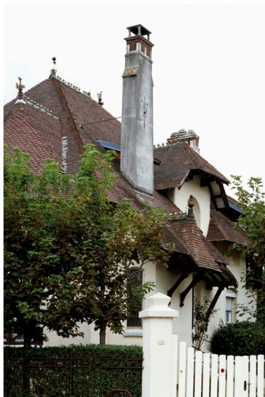
Vue générale depuis le portail. Phot. Philippe Dapvril IVR31_20076200052XA
