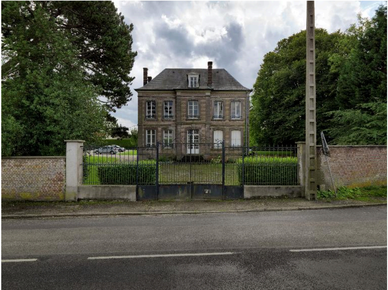
Vue générale depuis la rue du Chevalier-de-la-Barre.
