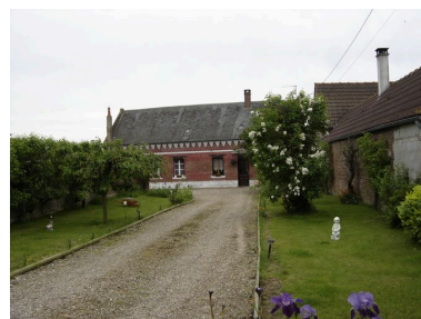
Ancienne ferme, 39 rue Louis-de-Rainvillers (1982 B2 270), début 20e siècle. Phot. Inès Guérin IVR22_20058005863NUCA
