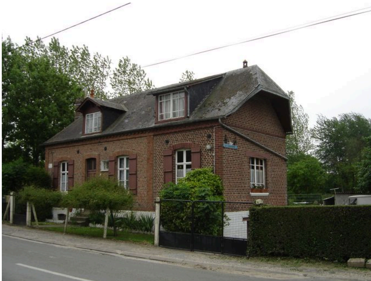
Maison, 1 rue Louis-de-Rainvillers (1982 ZE 124, 125), limite 19e 20e siècle.
