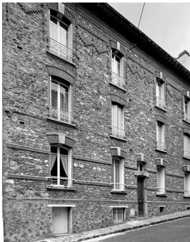
Détail des élévations. Phot. Thierry Lefébure IVR22_19960201105X
