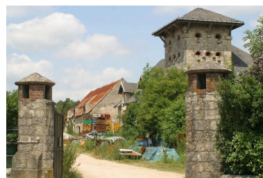
Entrée de la propriété. Phot. Inès Guérin IVR22_20030202300NUCA
