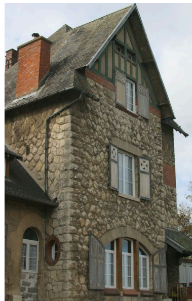
Vue du logis depuis la cour. Phot. Inès Guérin IVR22_20030202918NUCA
