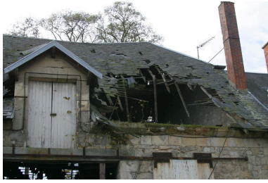
Etat actuel du bâtiment accolé au logis. Phot. Inès Guérin IVR22_20030202919NUCA
