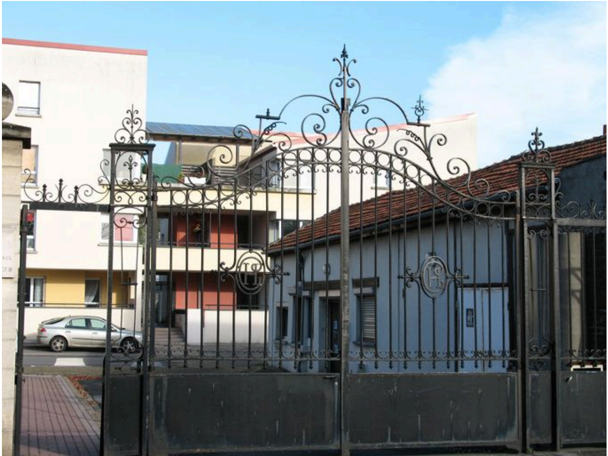
Portail d'entrée de la brasserie.
