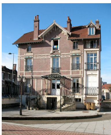
Façade est de la brasserie Gryson. Phot. Clarisse Lorieux IVR22_20076005549NUCA
