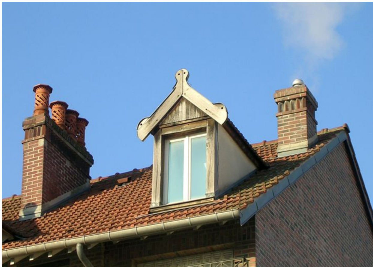
Détail de la toiture.
