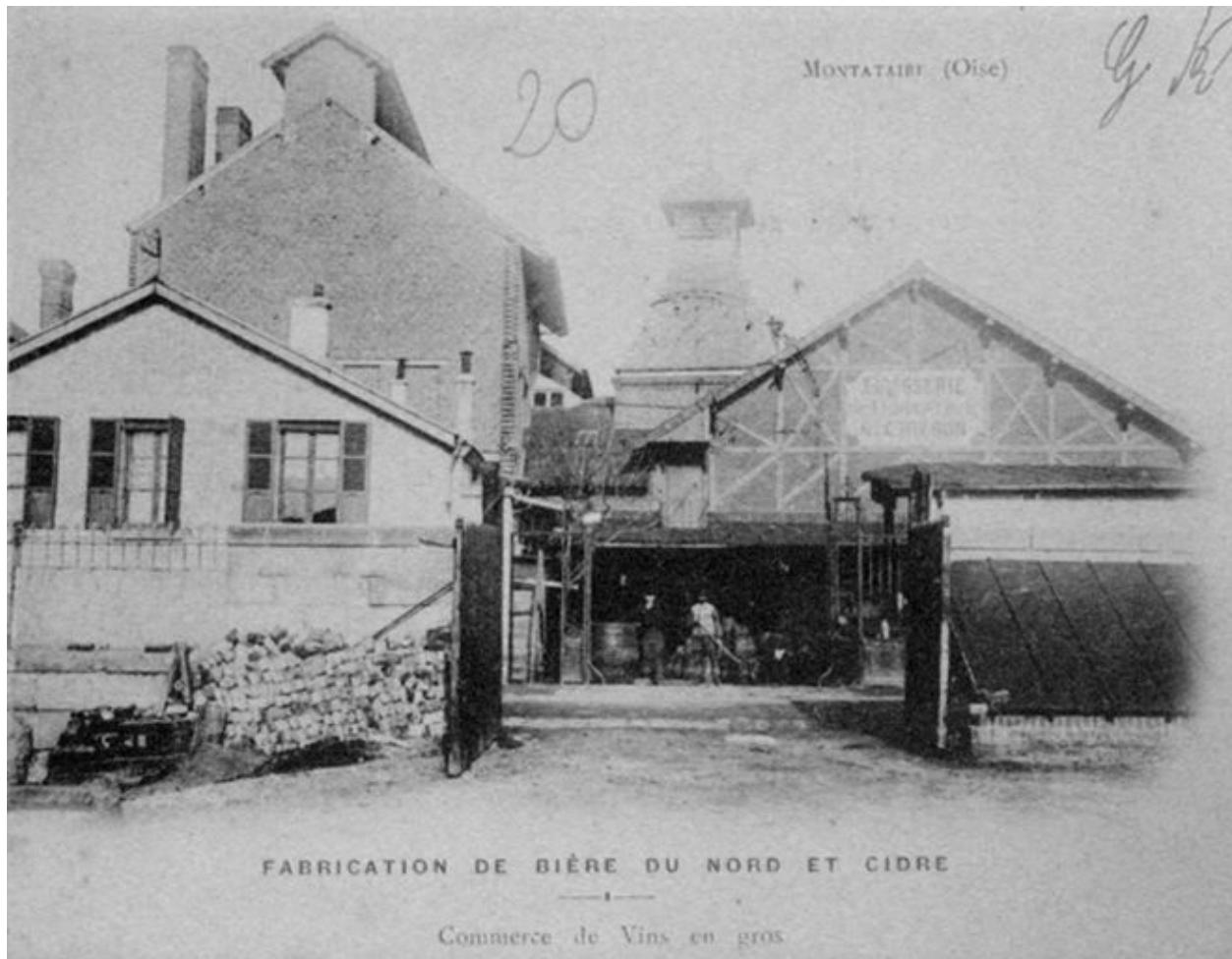
La brasserie et ses ateliers prise depuis le bras du bélier (AC Montataire).
