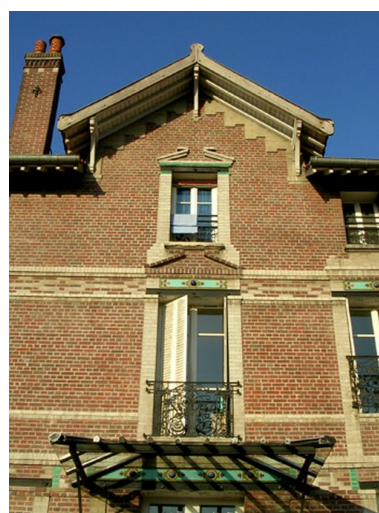
Détail de l'élévation de la façade de la brasserie. Phot. Clarisse Lorieux IVR22_20076005623NUCA
