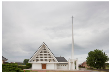
Vue générale vers le nord-est.
