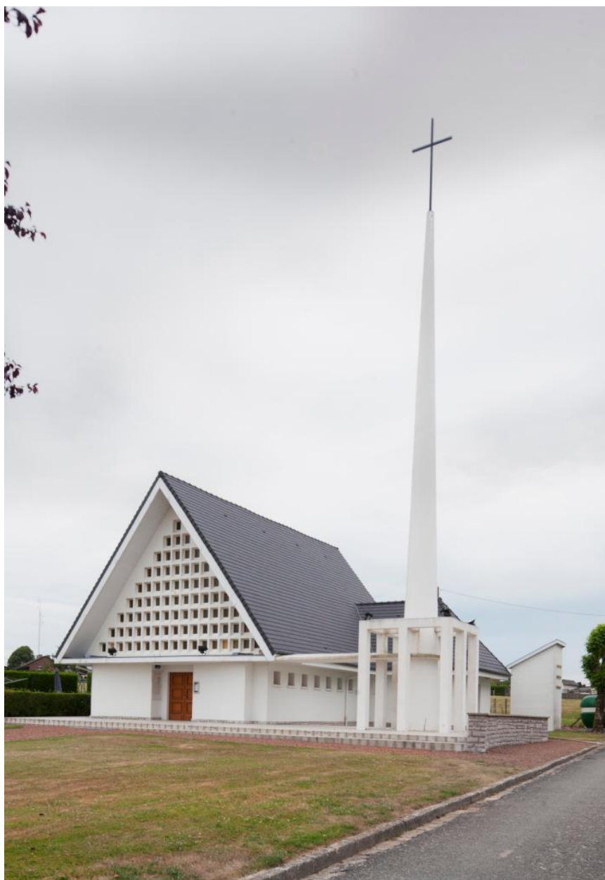
Vue de trois quarts, vers le nord.
