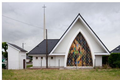
Élévation postérieure, vers l'ouest.
