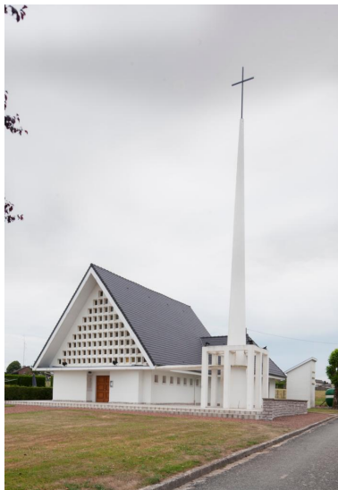
Vue de trois quarts, vers le nord.
