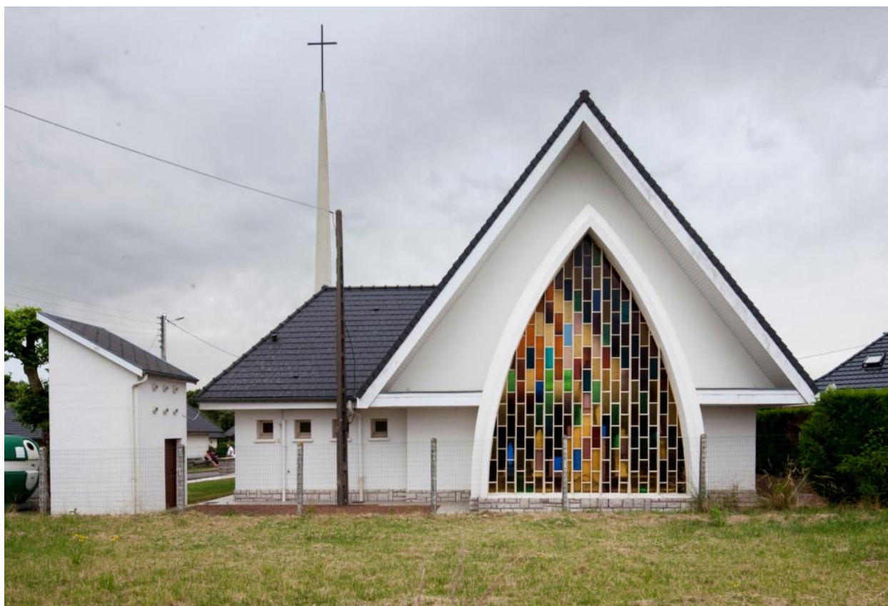
Élévation postérieure, vers l'ouest.
