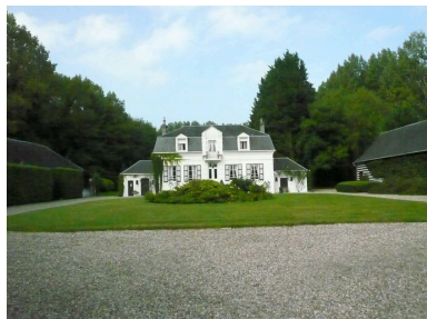
Vue du logis. Phot. Inès Guérin IVR22_20078006228NUCA
