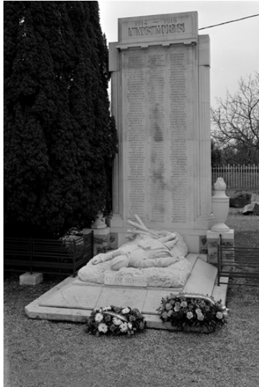
Vue d'ensemble. Phot. Thierry Lefébure IVR22_19940200313X
