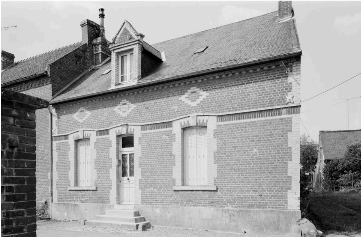
Maison repérée datée 1924. Élévation antérieure.
