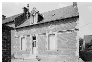
Maison repérée datée 1924. Elévation antérieure. Phot. Jean-Michel Périn IVR22_19846000984X
