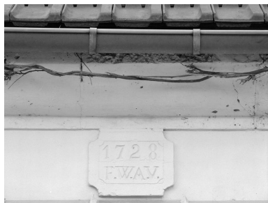
Vue de la corniche de la ferme repérée rue de l'Eglise (B1 40). Phot. Jean-Michel Périn IVR22_19846001038X
