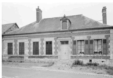
Maison repérée, V.C. n °1. Elévation antérieure. Phot. Jean-Michel Périn IVR22_19846001002X
