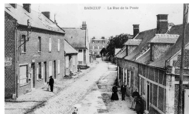
La rue de la Poste, avant 1914 (AP). Phot. Jean-Michel Périn (reproduction) IVR22_19856000322XB
