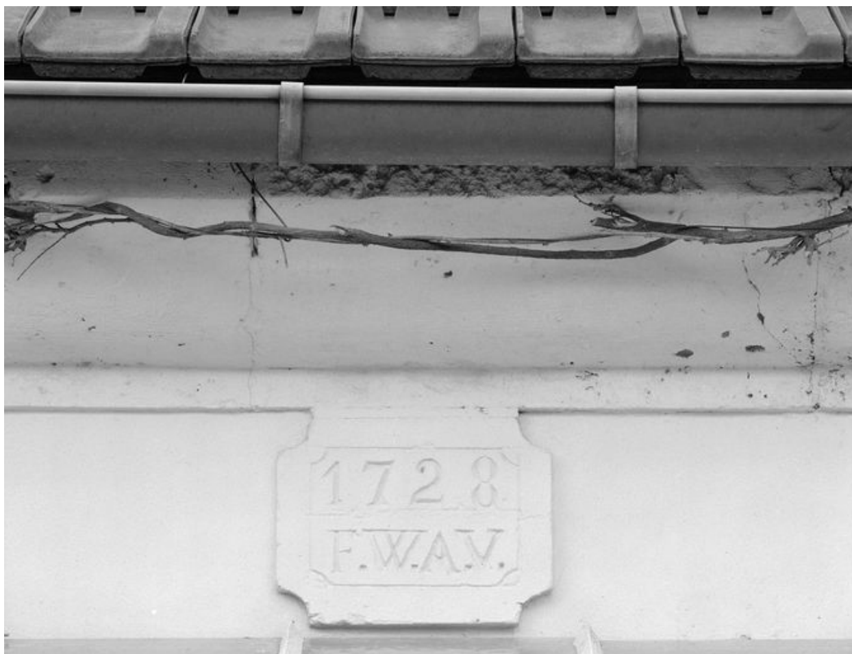
Vue de la corniche de la ferme repérée rue de l'Eglise (B1 40).
