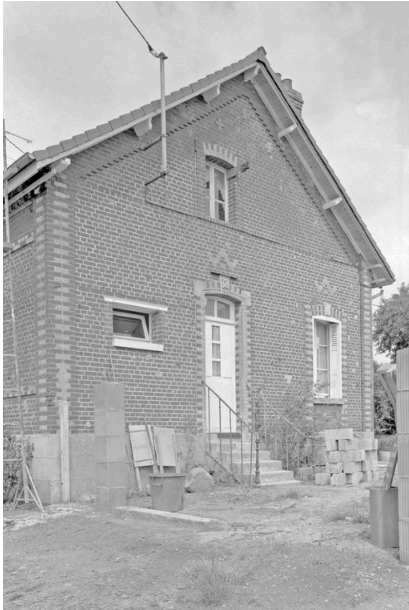
Maison repérée datée 1907. Détail du pignon.
