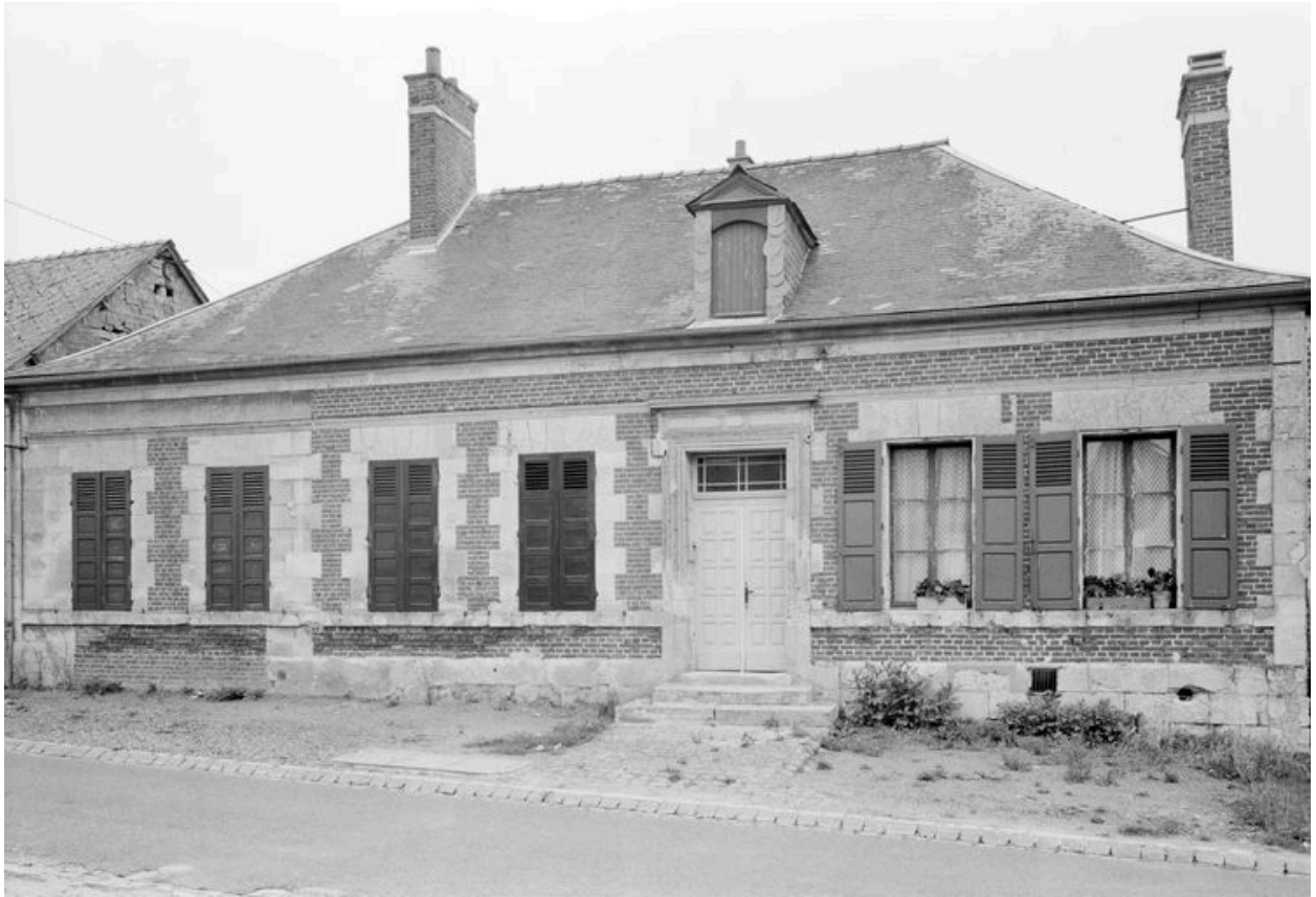
Maison repérée, V.C. n°1. Elévation antérieure.
