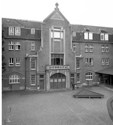
Élévation antérieure de la chapelle. Phot. Thierry Petitberghien IVR31_20015902279V
